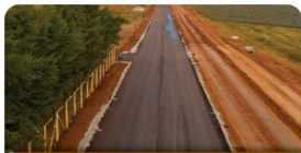
9km pavimentados - Algodão/Ferreiras
