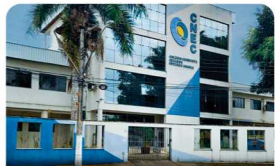
CNEC - Reforma de cozinha
