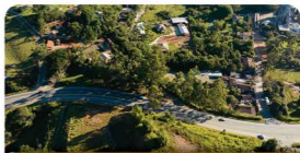
3km pavimentados - Cantagalo
