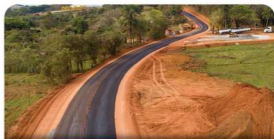
21km pavimentados Pantano dos Rosas
