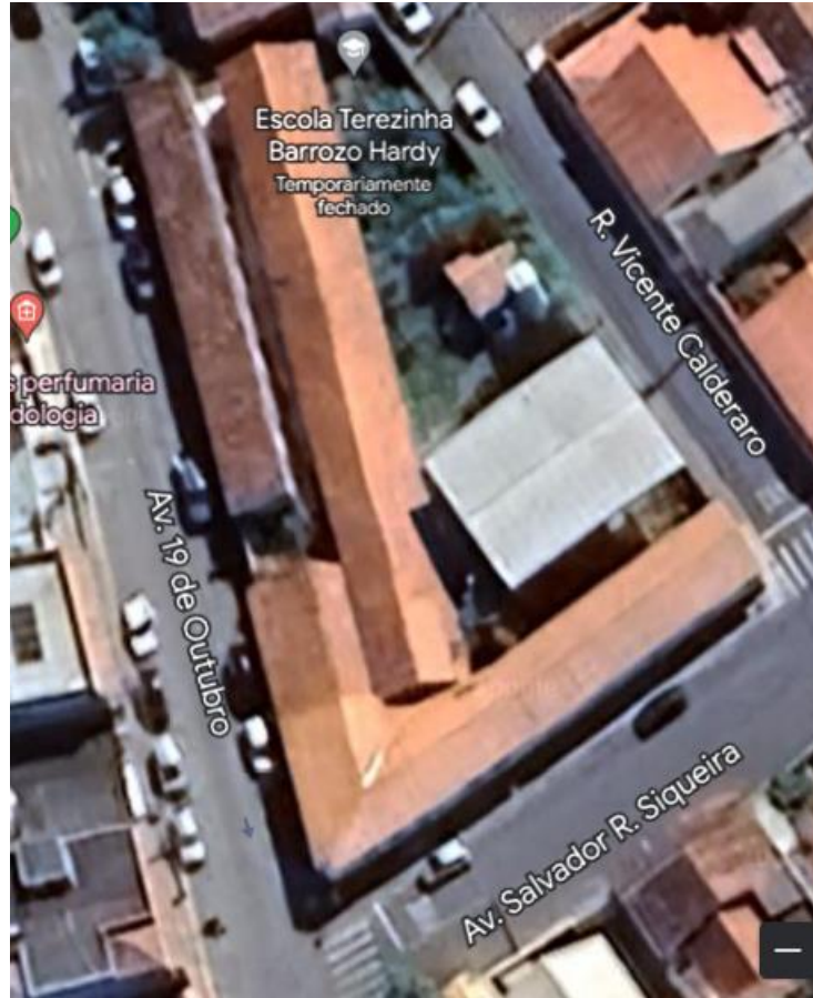
Figura 1 – Reforma do CEIM do bairro São Cristóvão.
