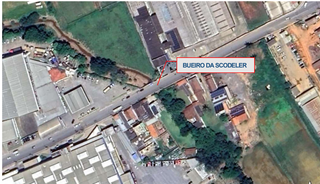
Figura 1-1 - Travessia da Ribeirão das Mortes na Rua Antônio Scodeler.
