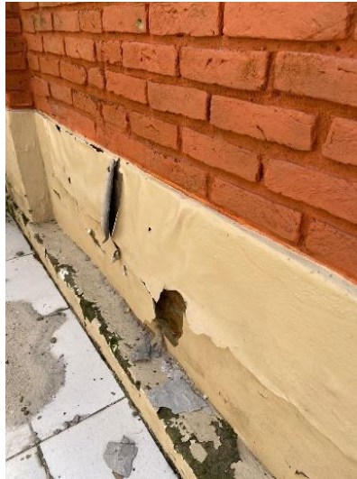
Figura 4-8 – Revestimento da área externa a ser removido
