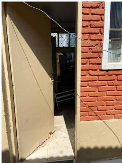
Figura 4-3 – Porta a ser removida, sem reaproveitamento.
