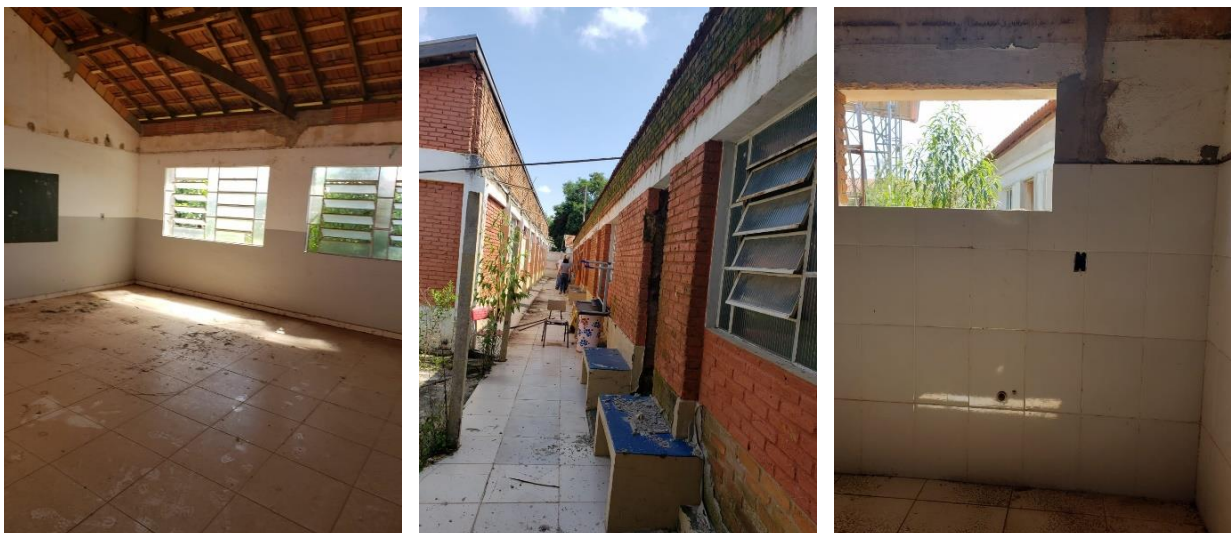
Figura 4-5 – Pisos e revestimento cerâmicos a serem demolidos
