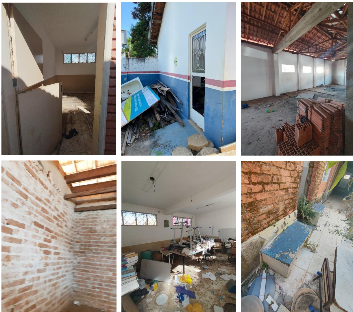
Figura 4-1 – Alvenarias a serem demolidas.
