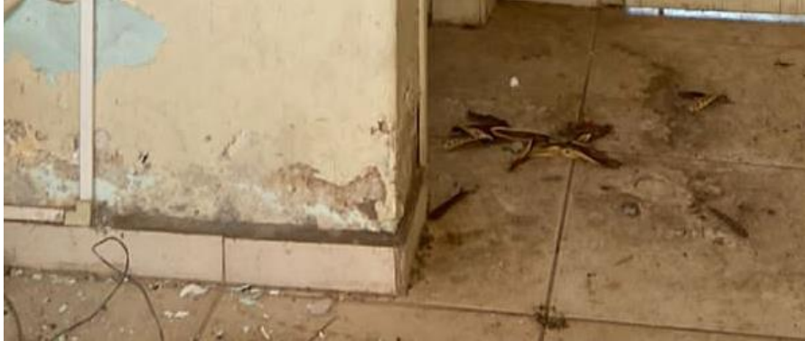
Figura 4-6 – Rodapés a serem demolidos
