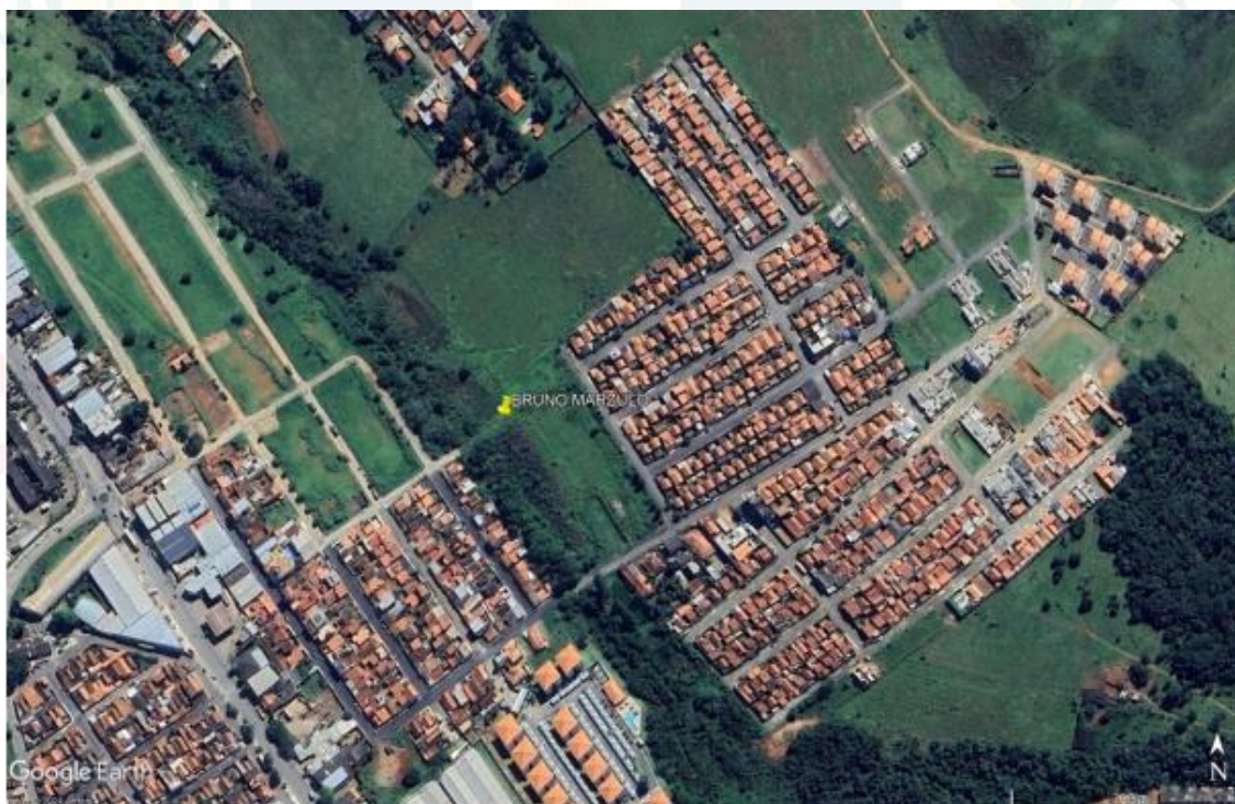
Figura 1 - Local de execução da obra de prolongamento viário – Rua Bruno Marzulo
