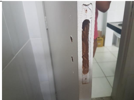
Porta sem fechadura
