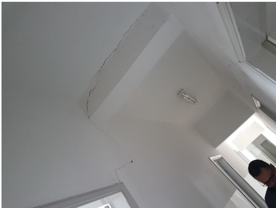
Figura 1 - Viga fissurada
