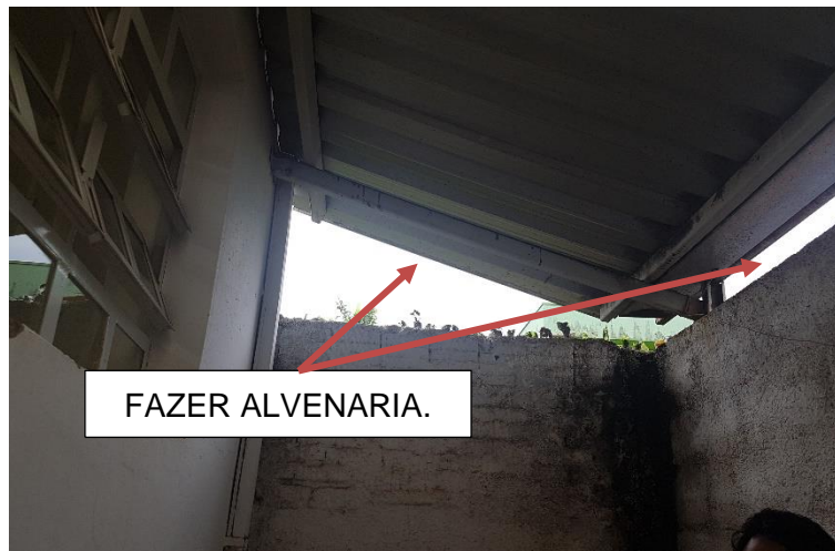
Figura 14 - Local a receber alvenaria
