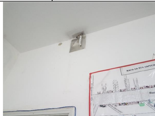
Instalação de espelho cego
