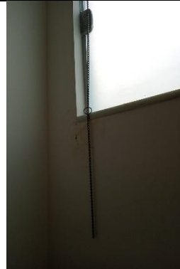
Troca da corrente de sustentação do basculante
