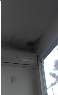
Ajuste do dreno e restauração das paredes
