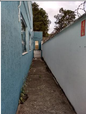
Paredes externas a serem revitalizadas
