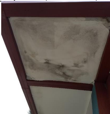
Troca de placas (área externa)
