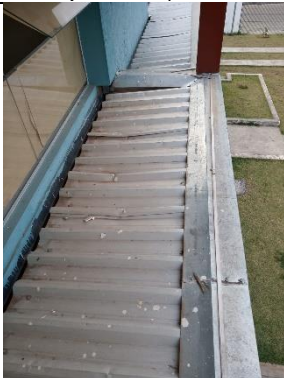
Troca de telhas danificadas.
