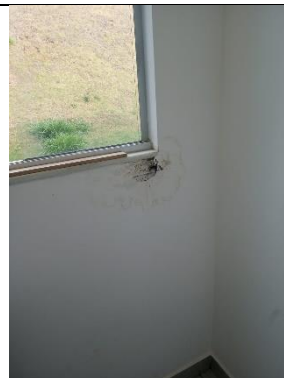
Tratamento de umidade nas janelas
