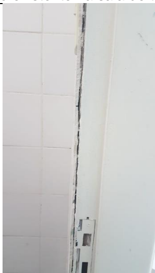
Azulejo onde será instalada cantoneira para acabamento
