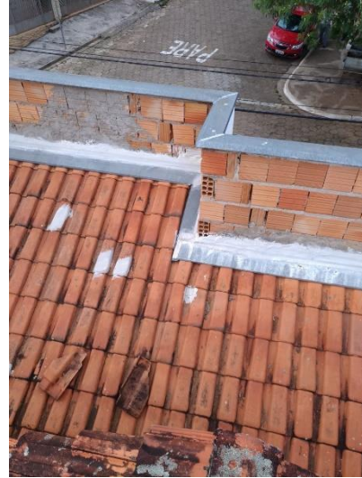
Face interna da platibanda
