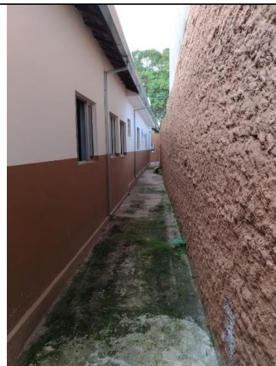
Corredor lateral onde serão instalados ralos
