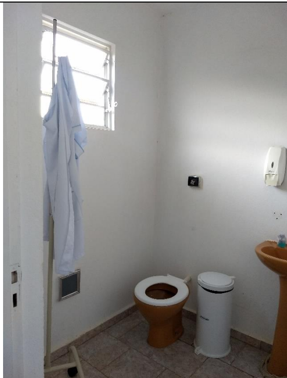
Um dos banheiros que receberam pastilhas.
