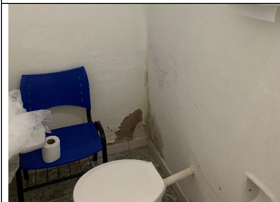
Paredes que serão tratadas até 0,5 m.
