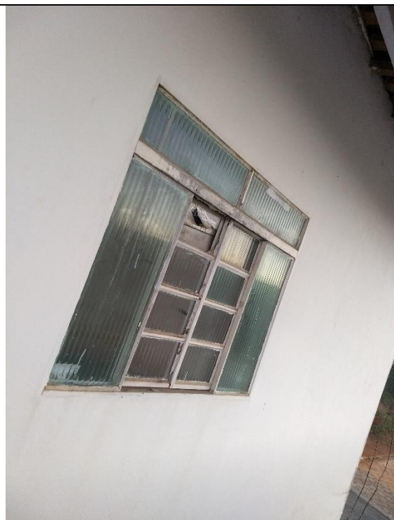
Janela a ser trocada do expurgo
