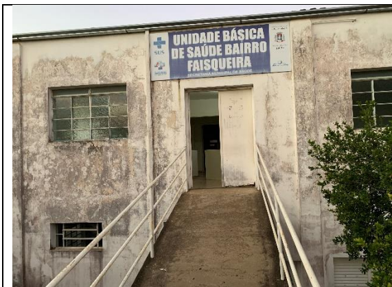
Placa a ser Substituída.
