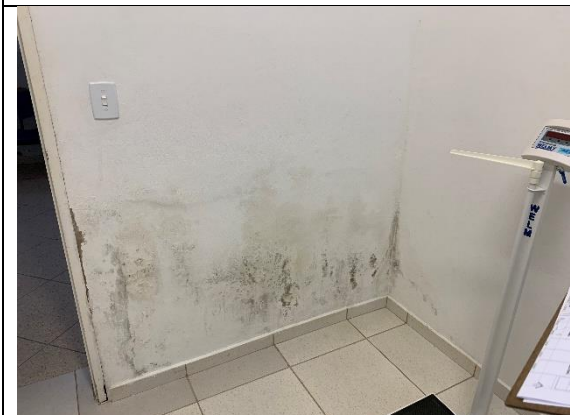
Paredes que serão tratadas até 1,0 m.
