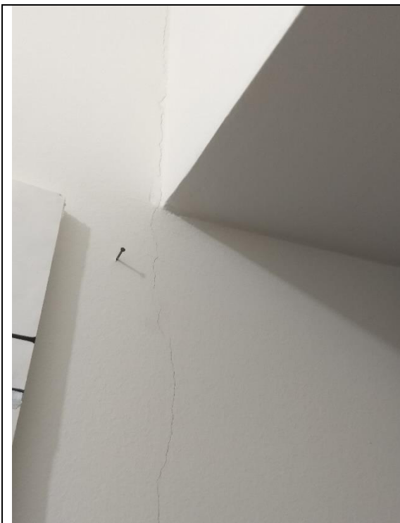
Tratamento da trinca de junção do corredor
