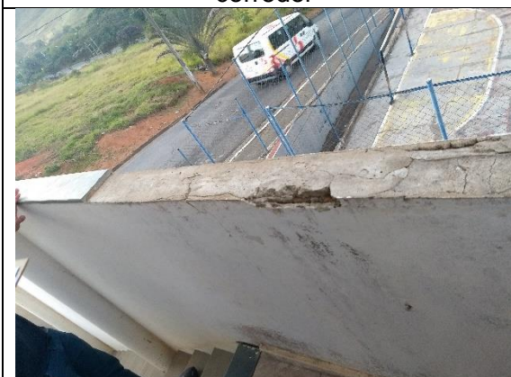
Guarda corpo que deve receber a instalação da ardósia
