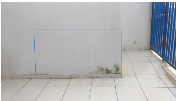
Figura 14- Local do abrigo de lixo
