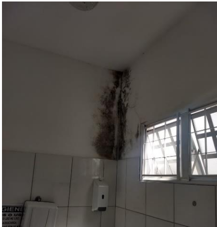
Tratamento da parede
