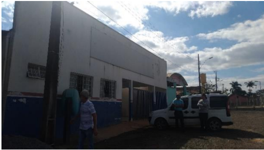
Placa a ser substituída.
