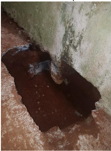
Lateral da UBS que receberá estrutura
