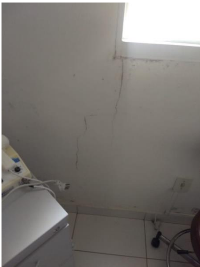
Tratamento da trinca
