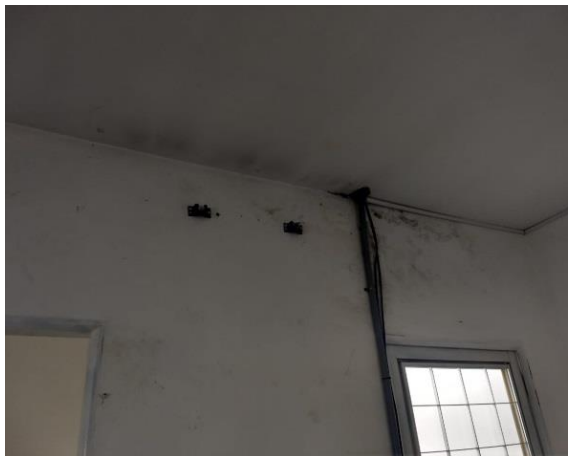
Tratamento das paredes
