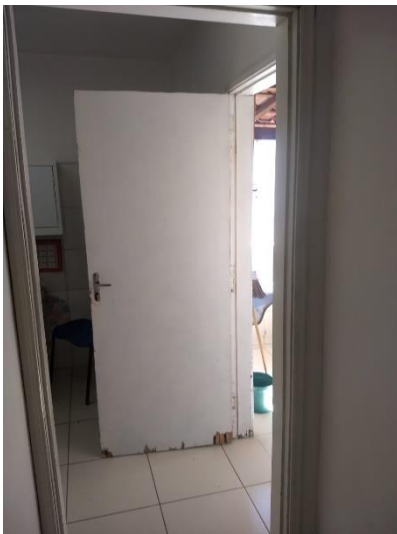
Porta a ser trocada e a ser instalada na cozinha
