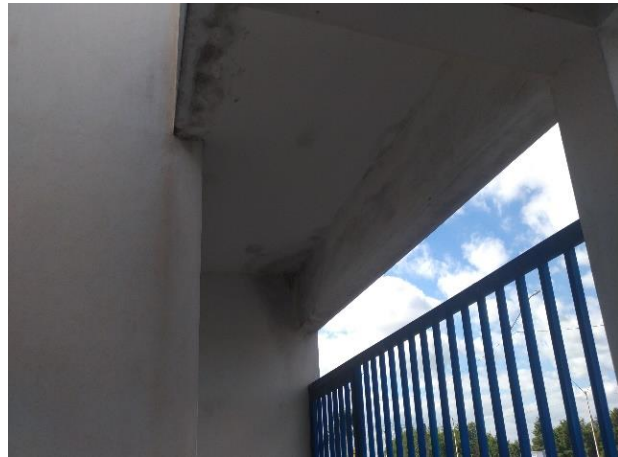
Tratamento do teto
