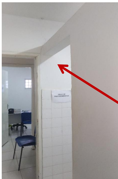
Figura 9- Viga a ser reforçada com apoio de pilar
