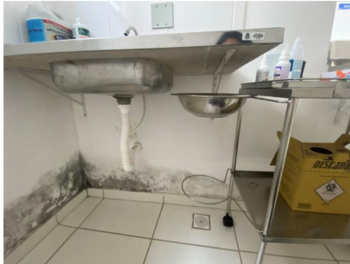
Figura 4-11 – Sifões existentes
