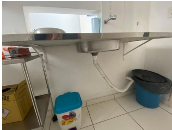
Figura 4-1 - Vão entre Lavagem e Esterilização
