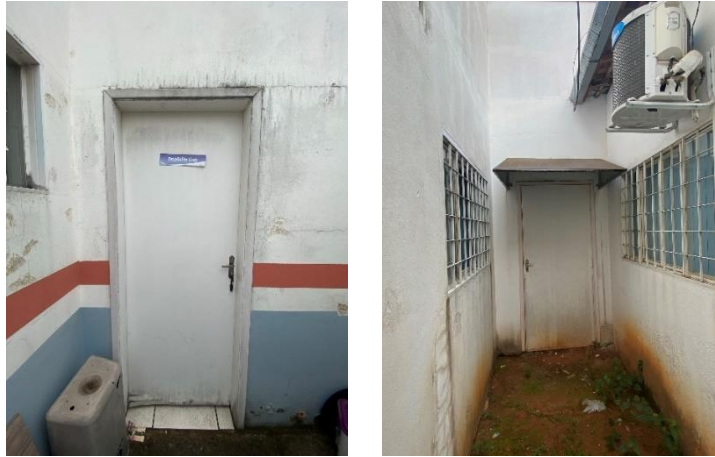
Figura 4-3 – Portas externas a serem substituídas
