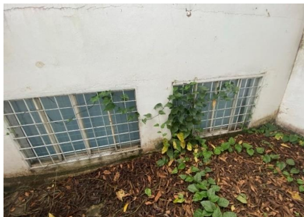
Figura 4-2 – Piso a ser demolido para instalação de canaleta
