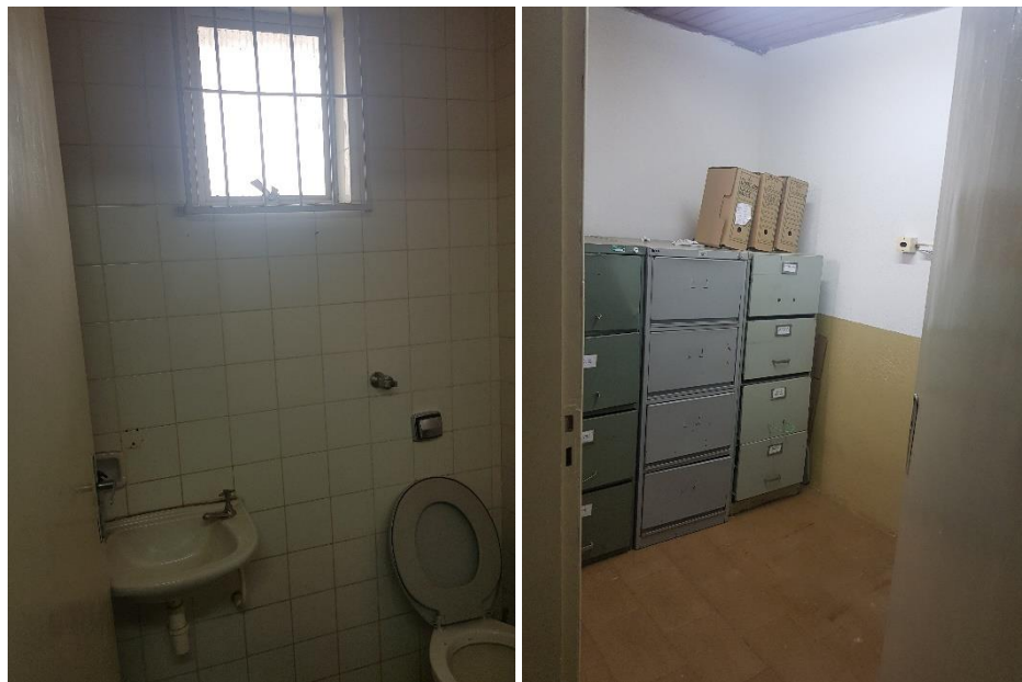
Figura 18 - Banheiro e Arquivo
