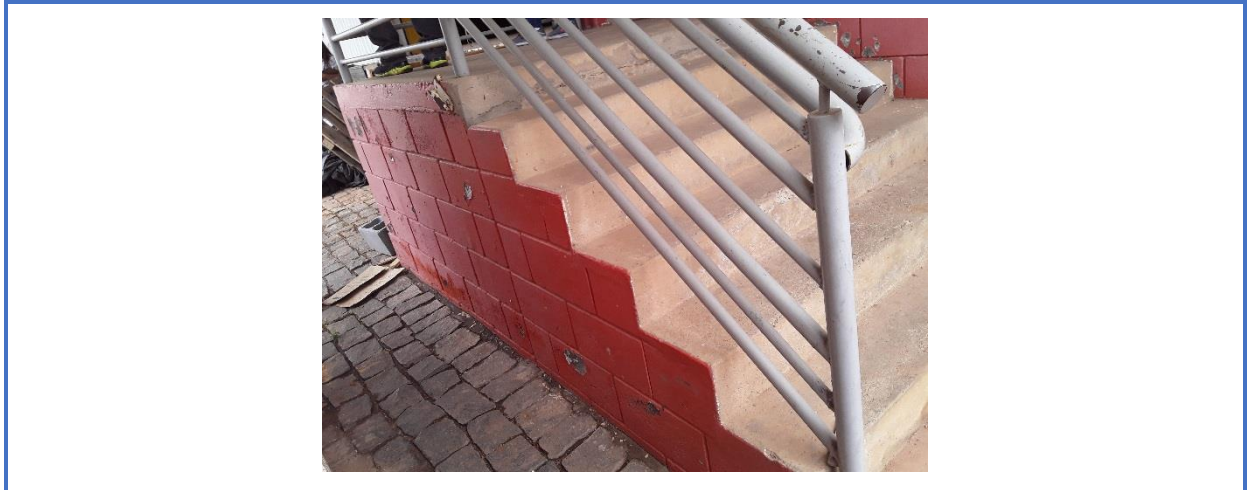
Figura 8 – Escada a ser demolida
