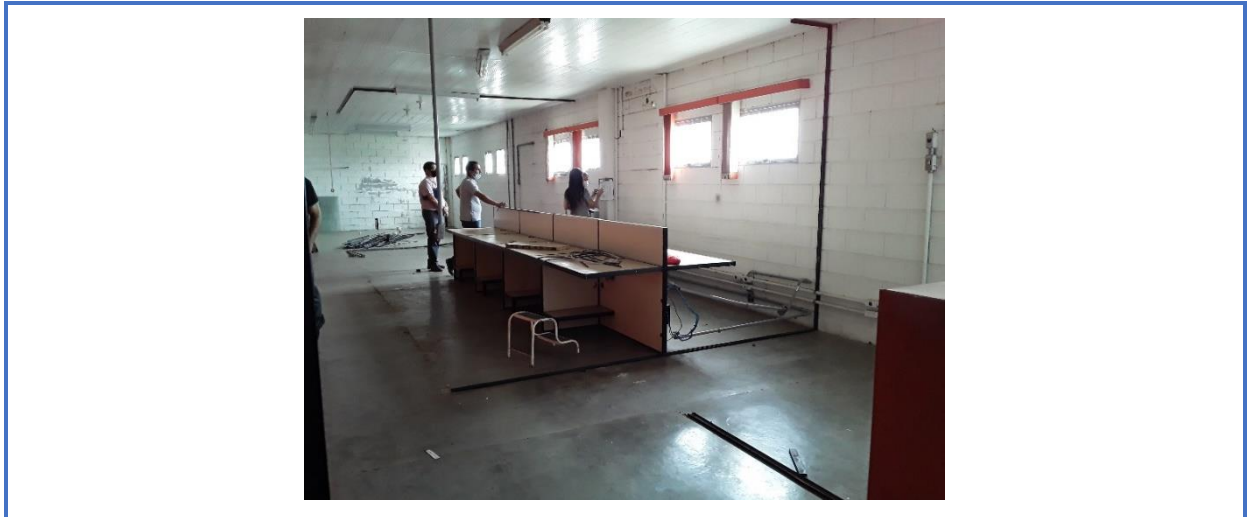
Figura 6 – Piso cimentado Salão superior a ser apicoado
