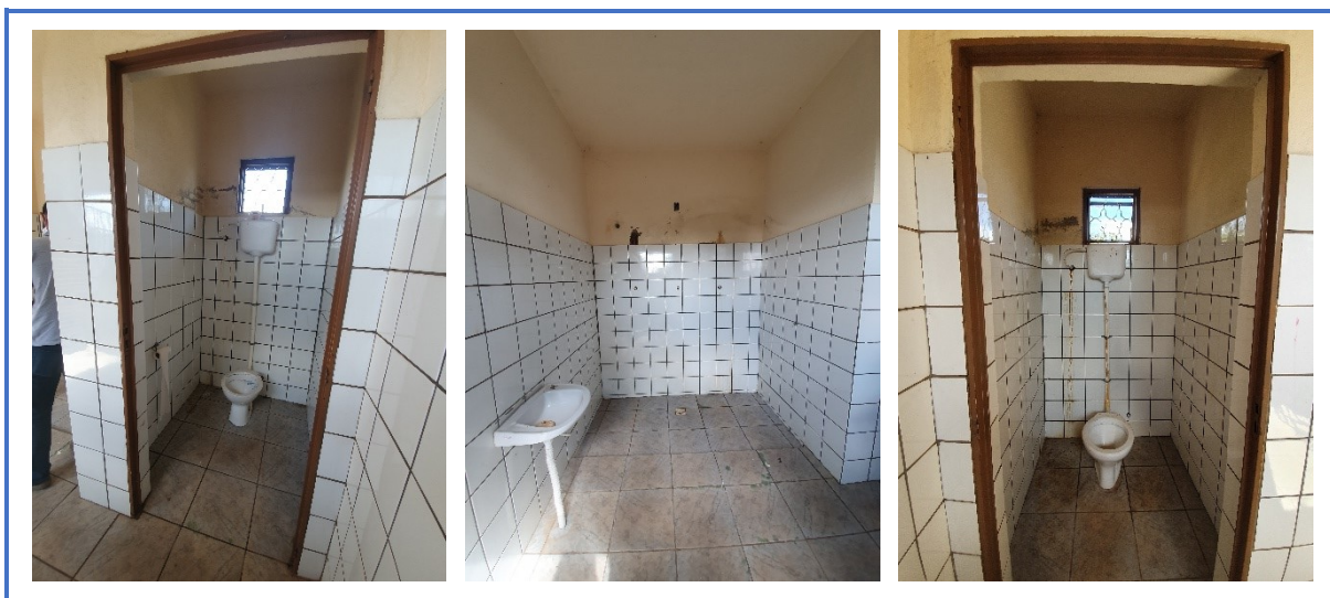
Figura 8 – Revestimento cerâmico e louças dos vestiários
