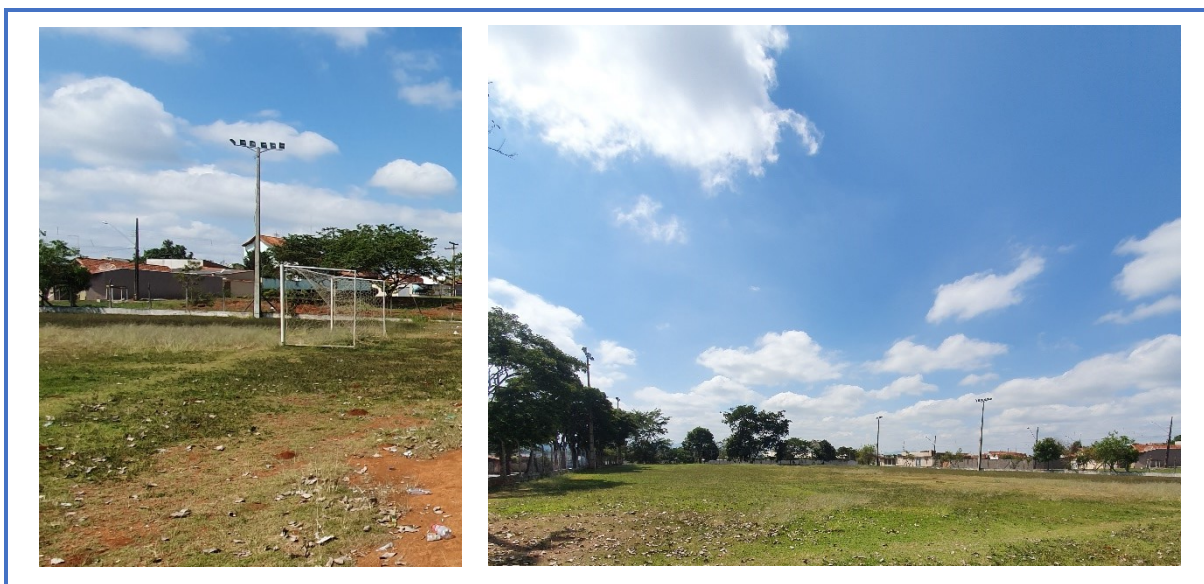
Figura 12 – Postes de iluminação
