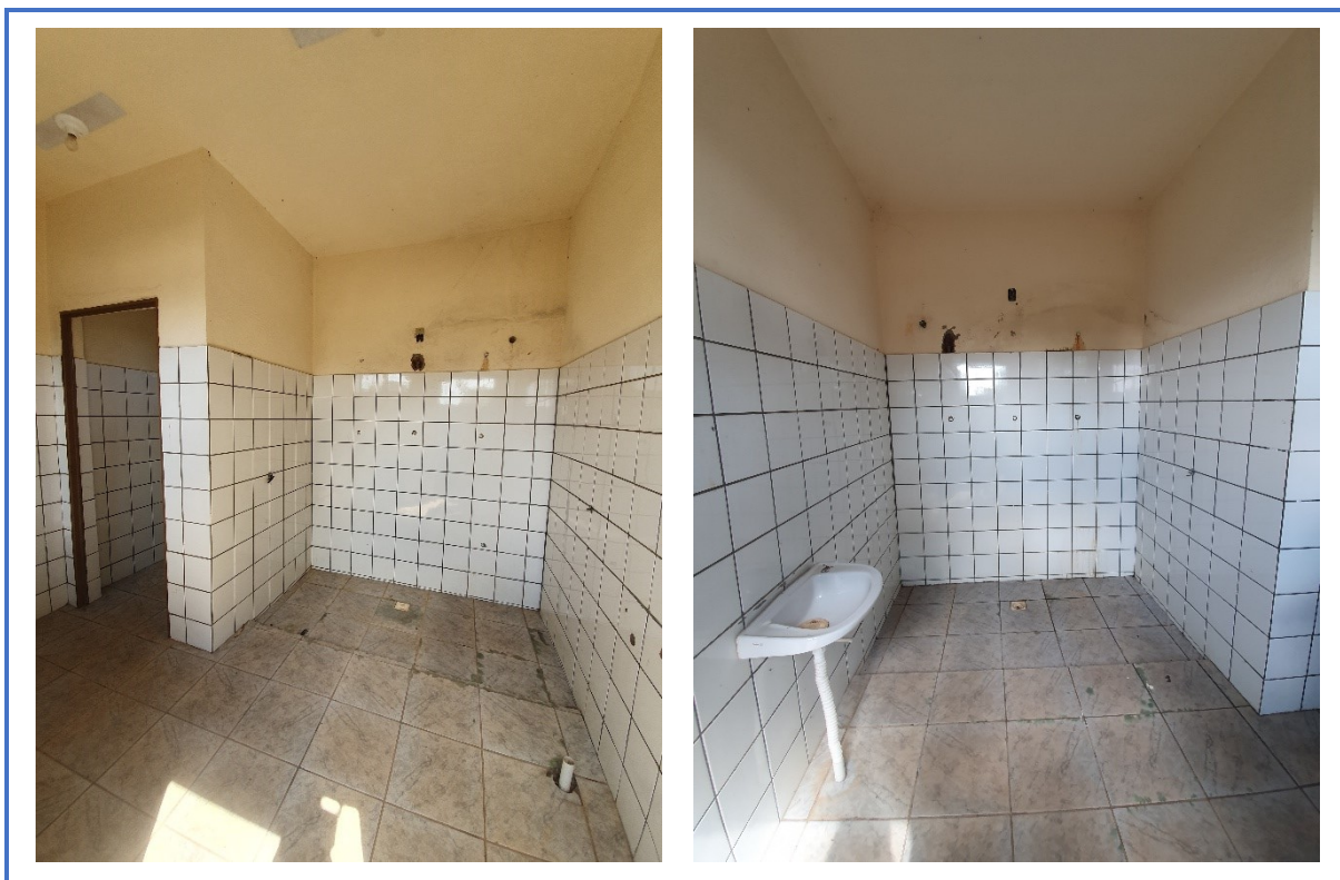
Figura 11 – Piso da área interna dos vestiários
