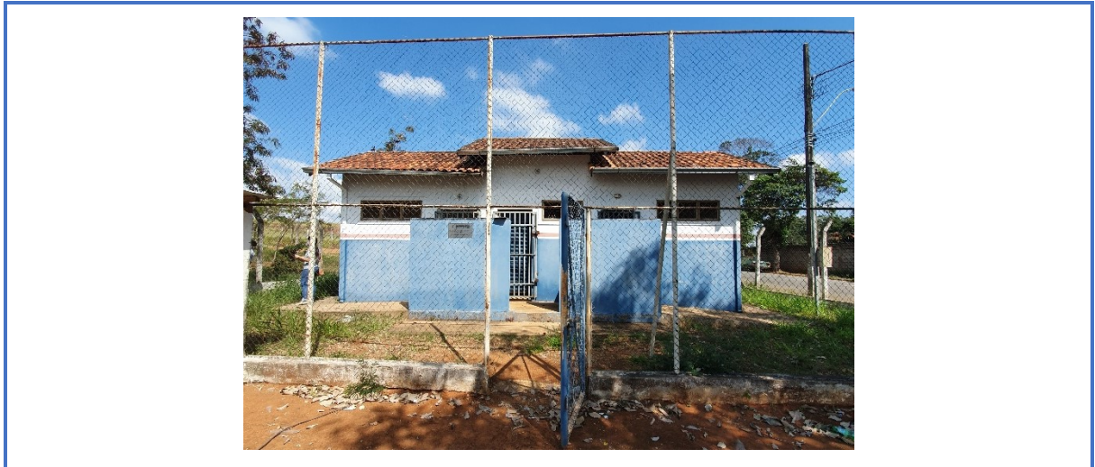
Figura 2 – Fachada dos vestiários
