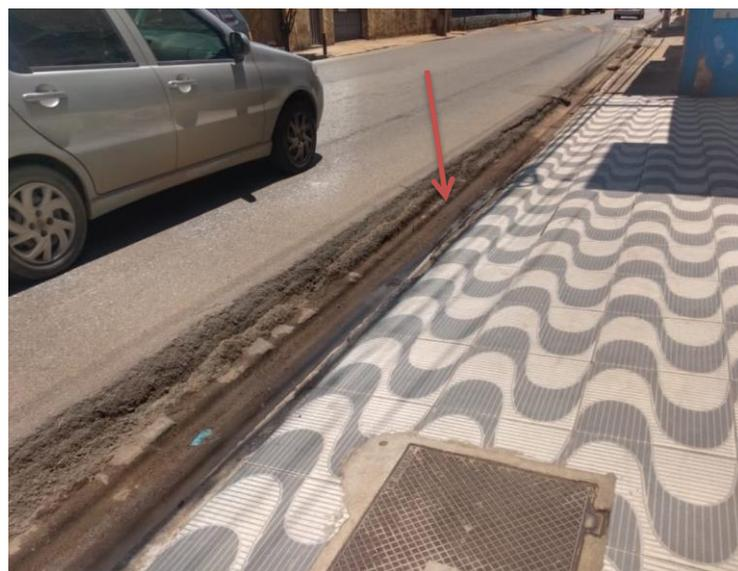
**Figura 9 - Desnível entre a pista e o meio fio onde será realizado um serviço de nivelamento em concreto para acertar a sarjeta.**
