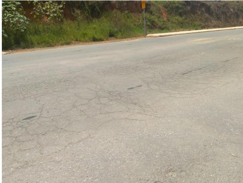
**Figura 2 – Trincas tipo “couro de jacaré” oriundas da fadiga de pavimento.**
