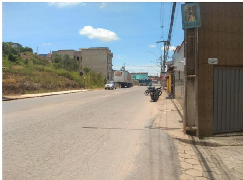
**Figura 3 - Pavimento deteriorado por fadiga de pavimento.**
