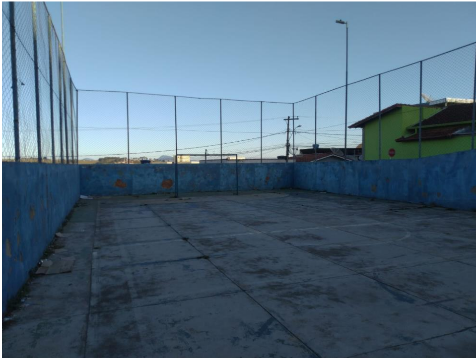
Figura 2-1 – Vista geral da quadra a ser reformada no Bairro Santo Ivo.
