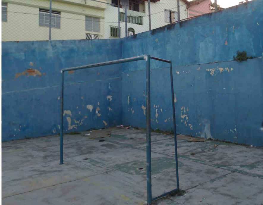
Figura 2-5 – Traves existente nas quadras
