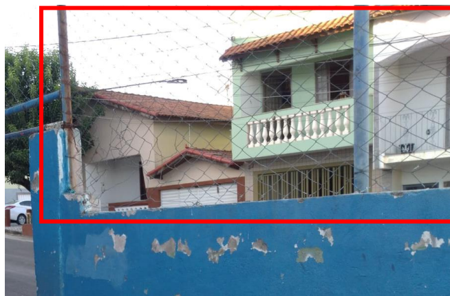
Figura 2-3 – Alambrado existente na quadra
