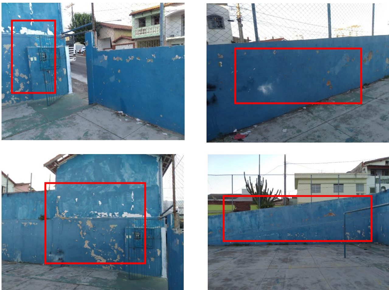
Figura 2-2 – Muro cercamento da quadra
