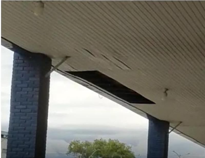
Figura 4-4 – Forro do teto cedeu e forro danificado.
