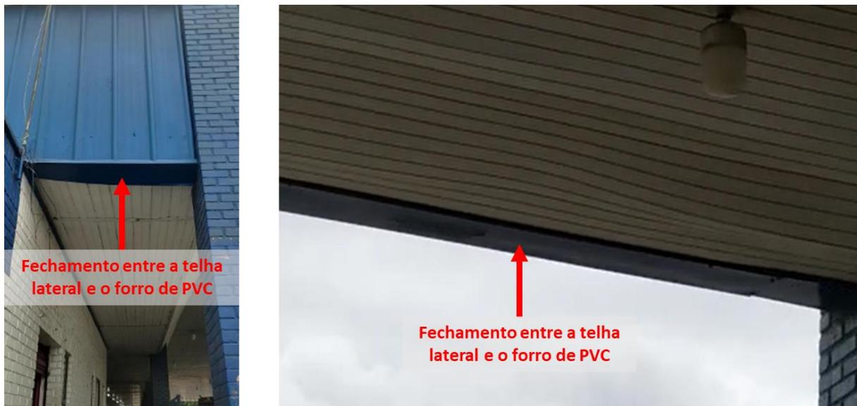
Figura 4-1 – Fechamento entre a telha lateral e o forro de PVC.
