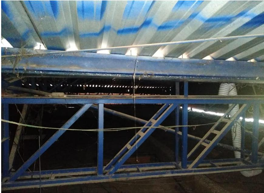
Figura 4-6 – Sujeira na estrutura metálica.
