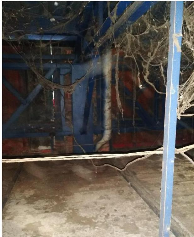
Figura 4-7 – Sujeira na estrutura metálica e no forro.
