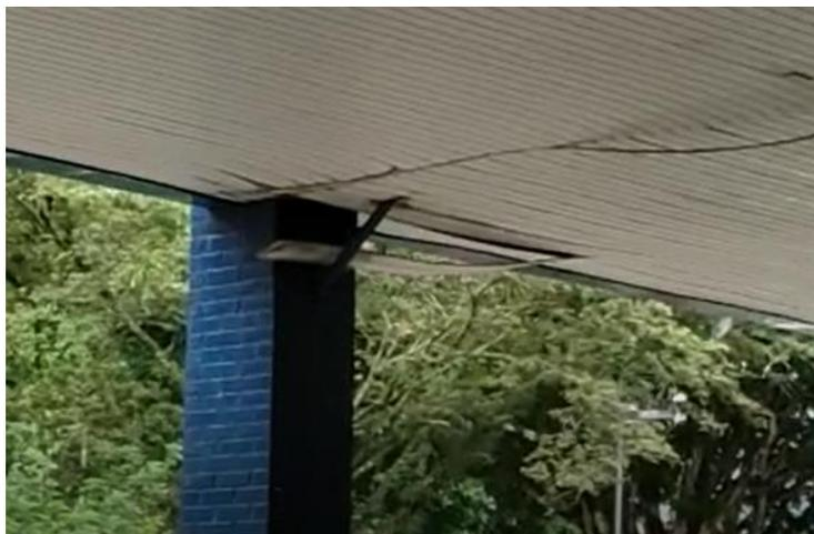
Figura 4-5 – Forro e junta danificados.
