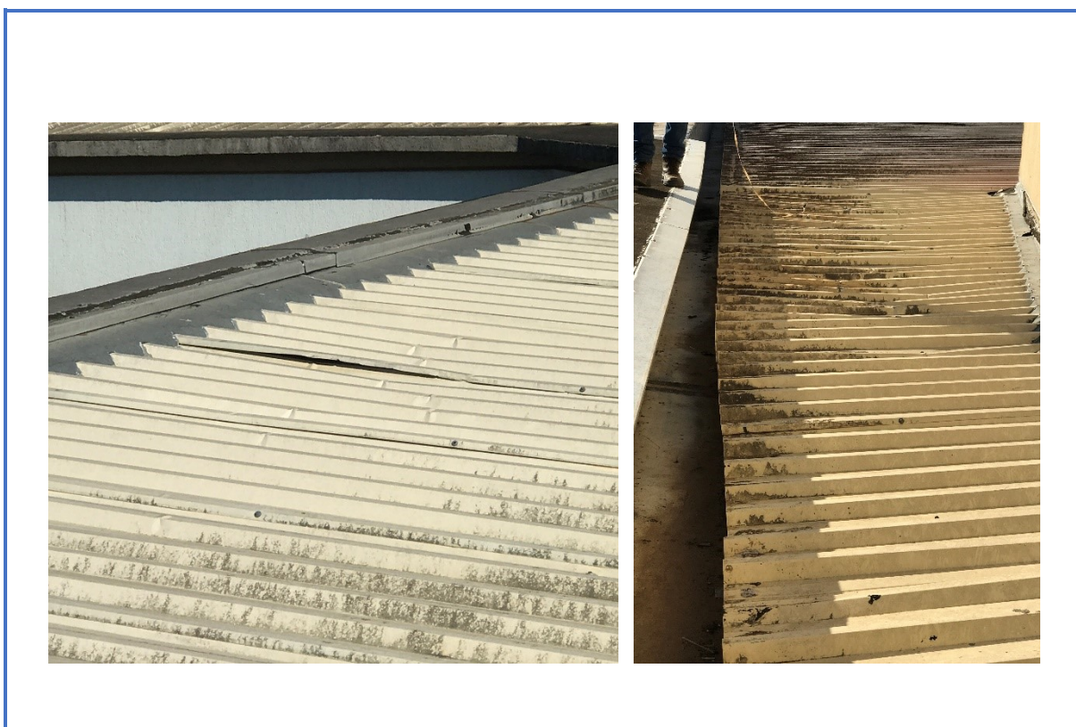
Figura 4 – Telhas Danificadas
