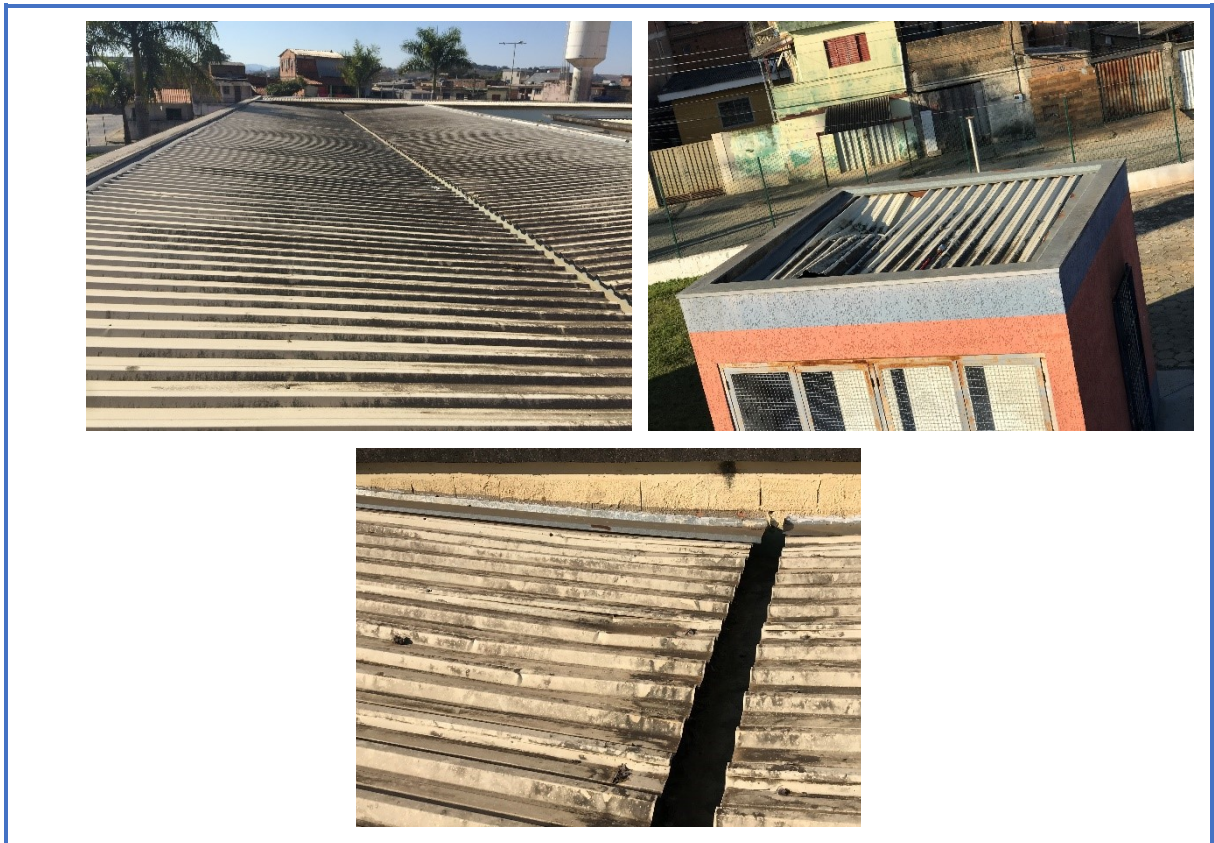
Figura 2 – Telhado da Policlínica Municipal
