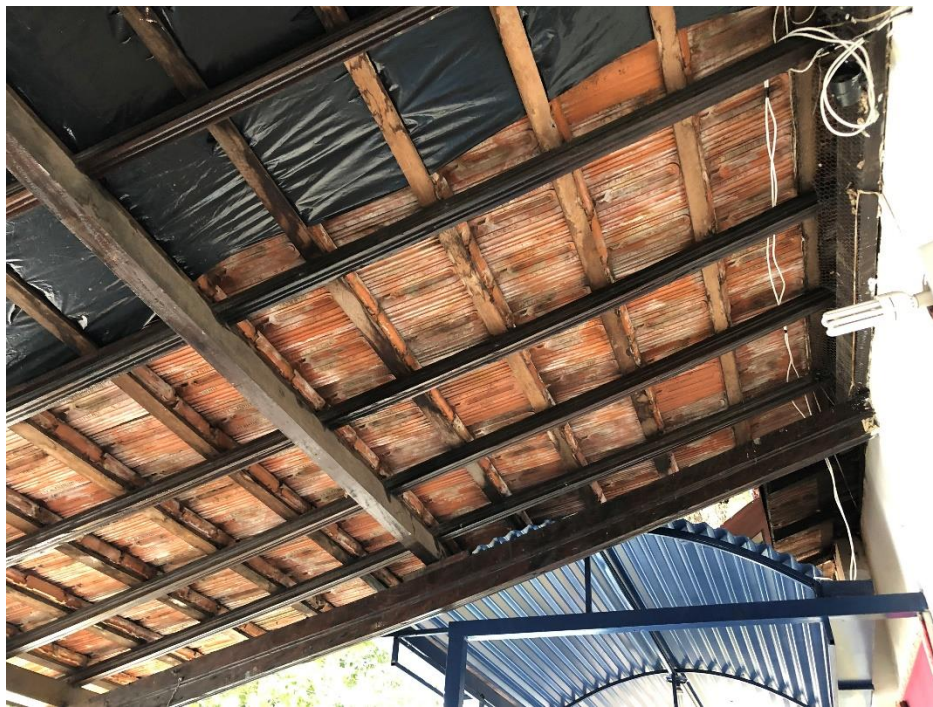
Figura 21 - Telhado Bloco I
