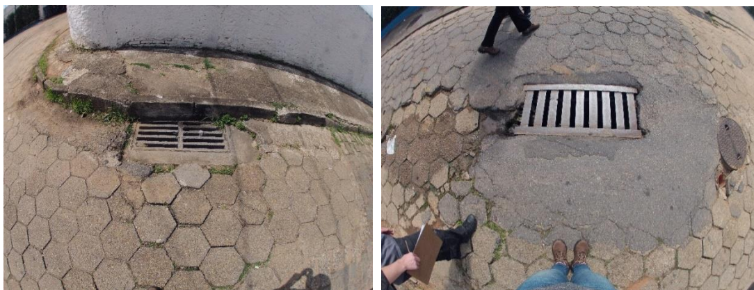
Figura 3.2 - Boca de leão e grelhas no eixo da via.
