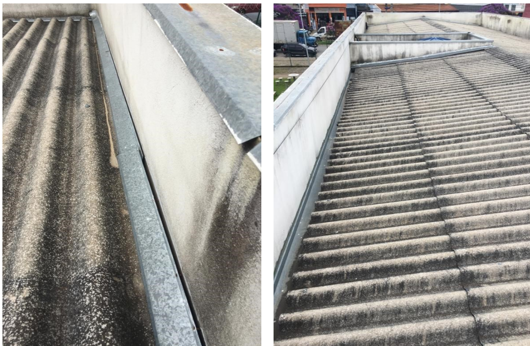
Figura 4 - Cobertura e seus Elementos do Bloco 02
