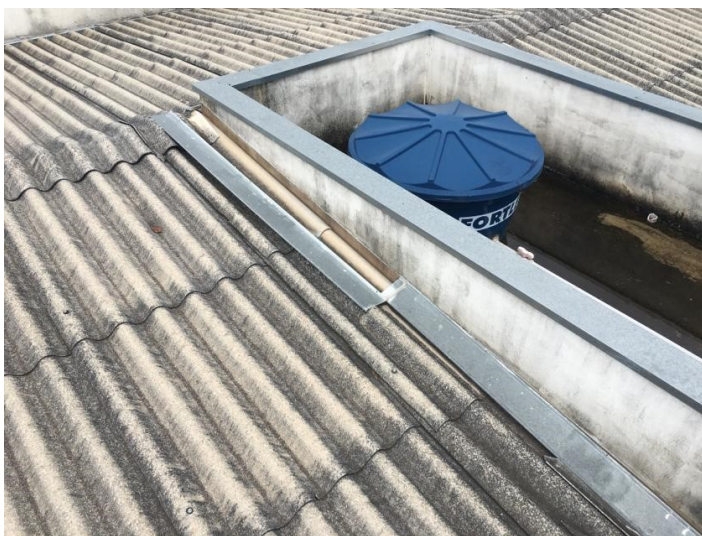
Figura 6 - Caixa d'Água Bloco 02
