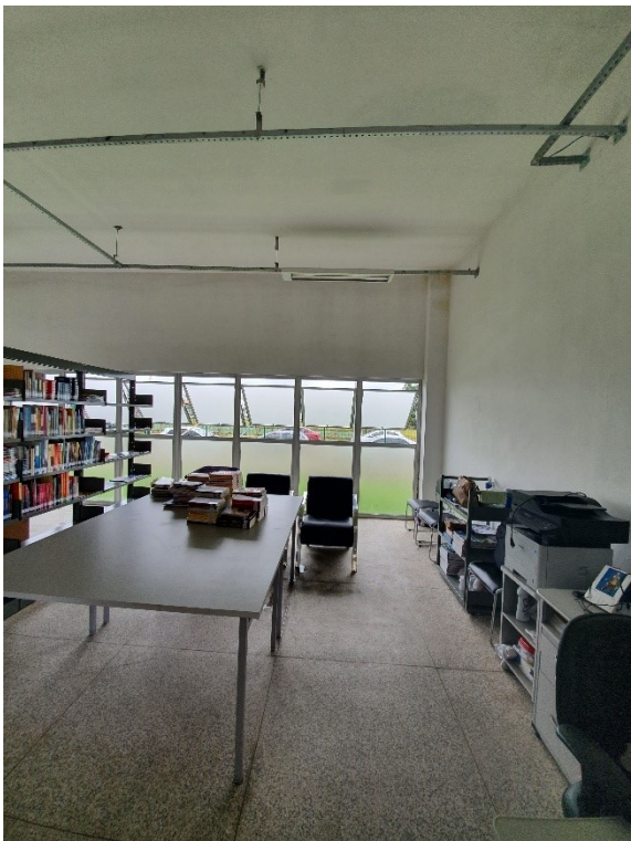
Figura 12 - Piso Granilite Bloco 01 e Bloco 02
