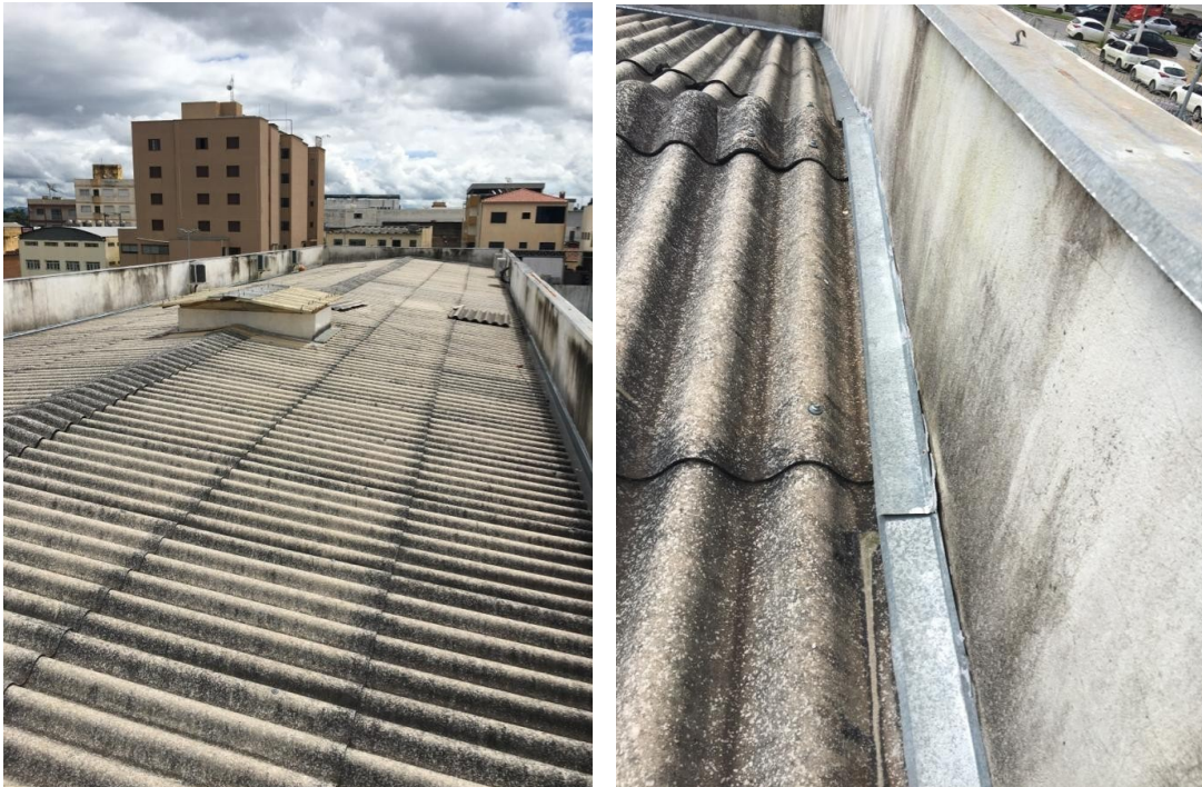
Figura 3 - Cobertura e seus Elementos do Bloco 01
