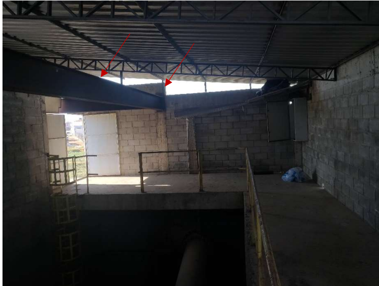
Figura 8-1 - Área a ser fechada com alvenaria
