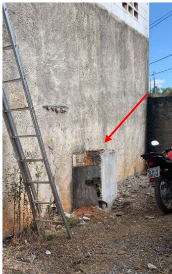
Figura 6-3 - Alvenaria a ser demolida
