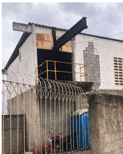
Figura 8-2 - Área externa da casa de bombas
