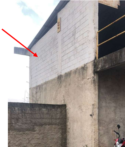
Figura 6-1 - Local a ser demolido Fonte: DAC Engenharia
