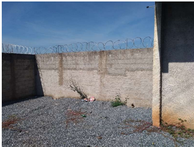
Figura 6-6 – Área externa a ser realizada a limpeza
