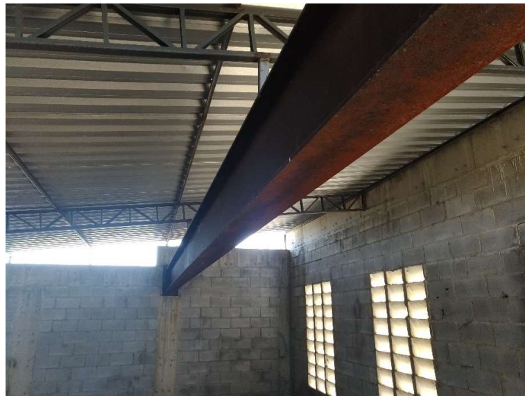
Figura 20-2- Vigas com perfil 01 Fonte: DAC Engenharia
