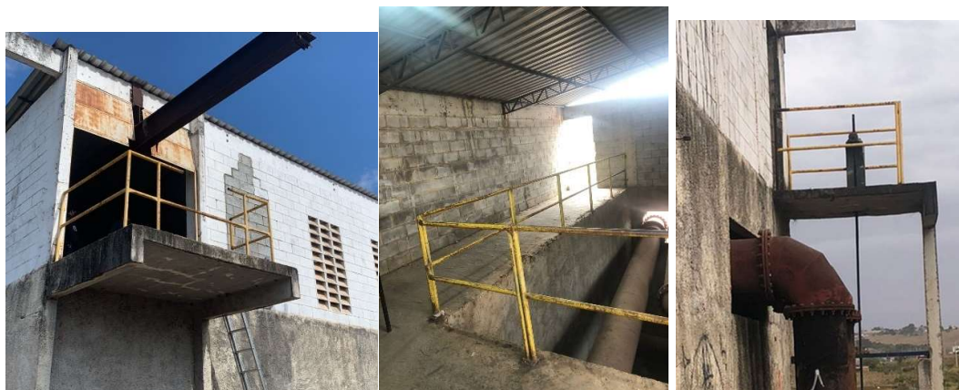
Figura 6-4 – Guarda corpo a serem removidos
