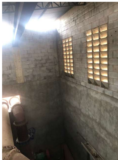
Figura 6-2 - Blocos vazados a serem demolidos
