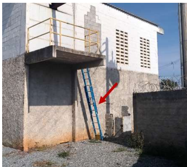
Figura 36 - Escada de acesso - DIQUE 02
