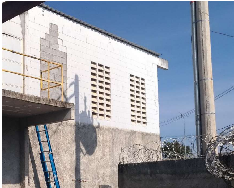
Figura 32 - Blocos vazados - DIQUE 02
