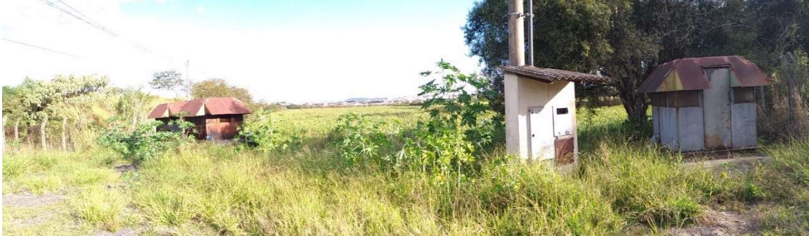
Figura 23 - Área externa da casa de máquinas - DIQUE 01
