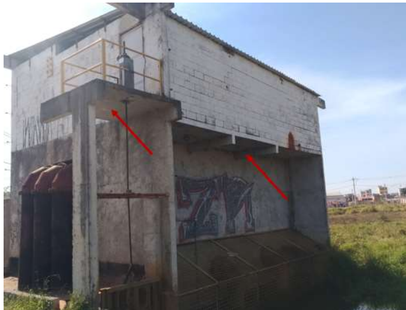
Figura 28 - Tetos externos - DIQUE 02
