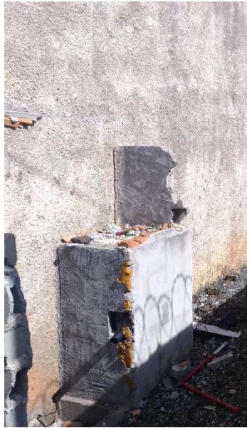
Figura 29 - Alvenaria a ser demolida - DIQUE 02
