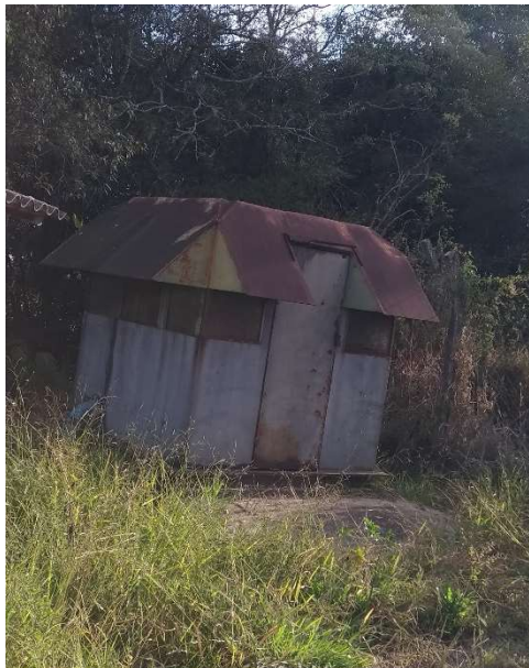
Figura 6 - Esquadrias das edificações - DIQUE 01
