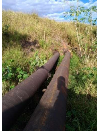
Figura 22 - Tubulações que receberão estruturas metálicas - DIQUE 01
