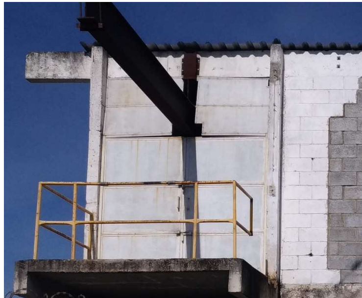
Figura 39 - Guarda-corpo externo - DIQUE 02
