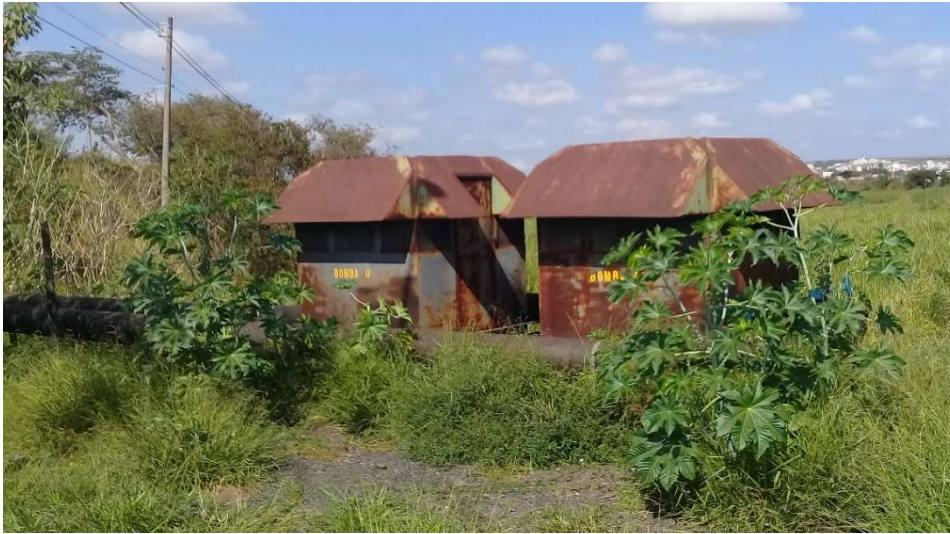
Figura 8 - Casa de abrigo das bombas - DIQUE 01
