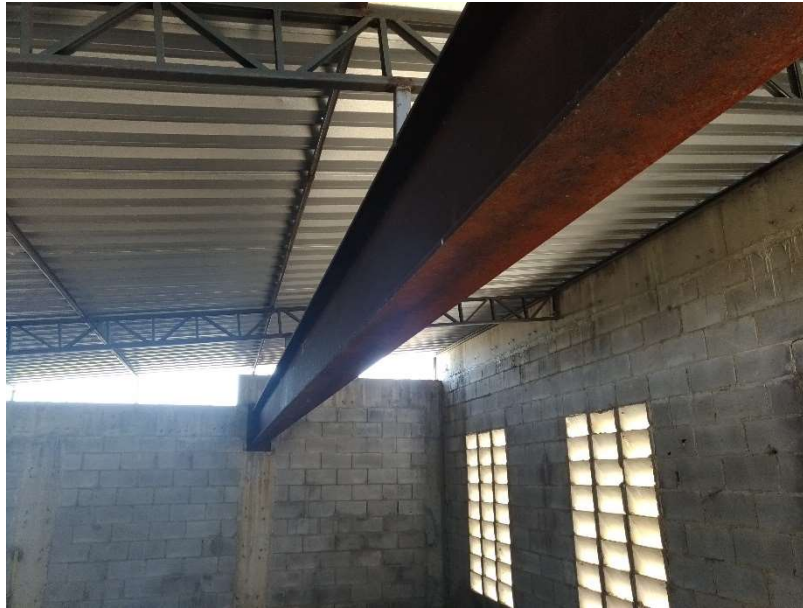
Figura 24 - Cobertura e viga em perfil 01 - DIQUE 02
