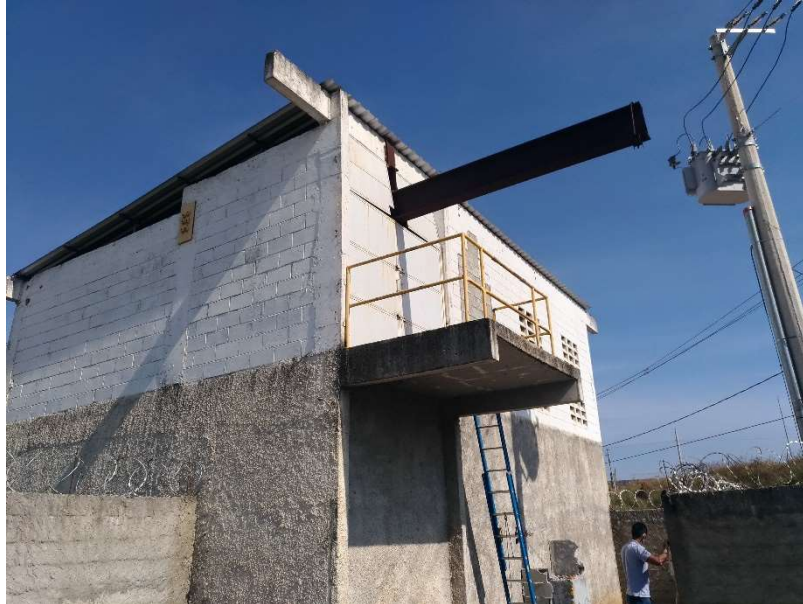
Figura 26 - Área externa da casa de máquinas - DIQUE 02
