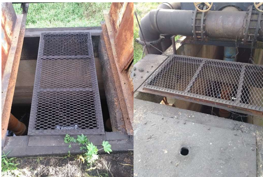
Figura 7 - Piso de proteção - DIQUE 01
