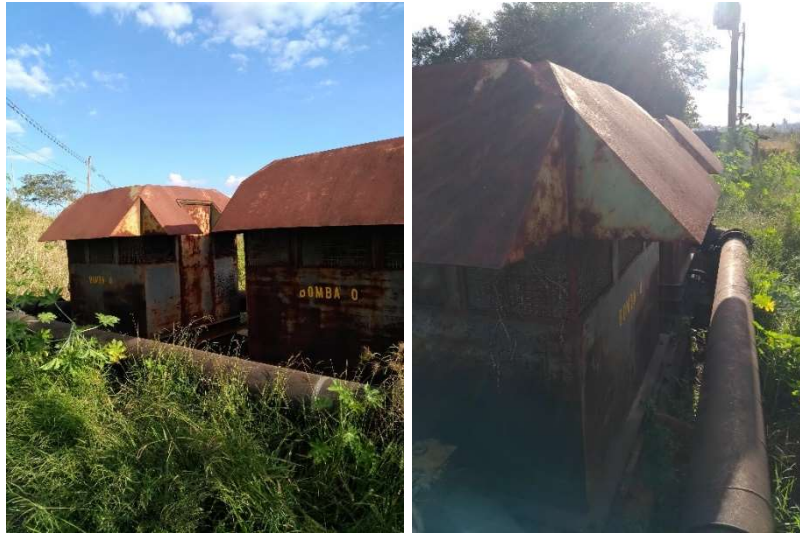
Figura 4 - Edificações da casa de máquinas - DIQUE 01
