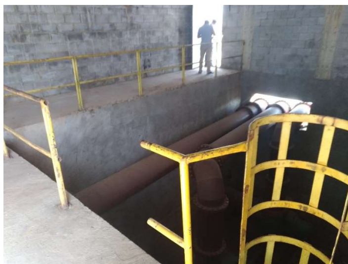
Figura 38 - Guarda-corpo interno - DIQUE 02
