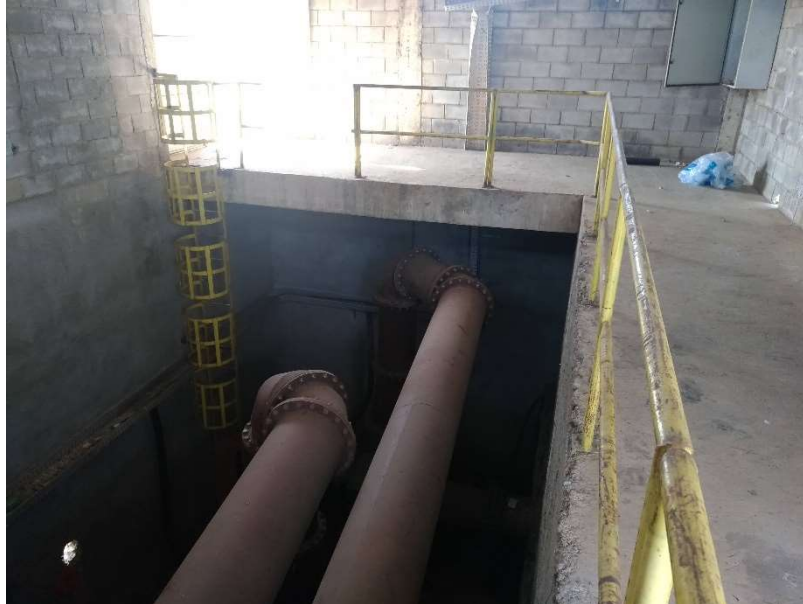
Figura 45 - Piso interno - DIQUE 02
