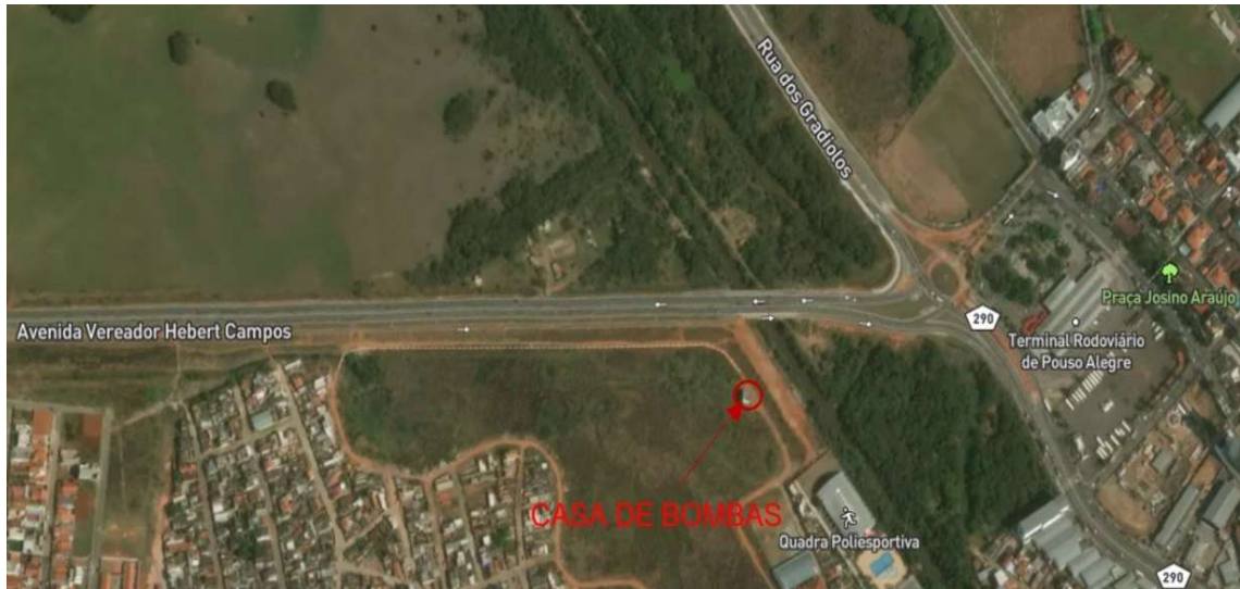
Figura 2 - Localização da casa de bombas da DIQUE 02
