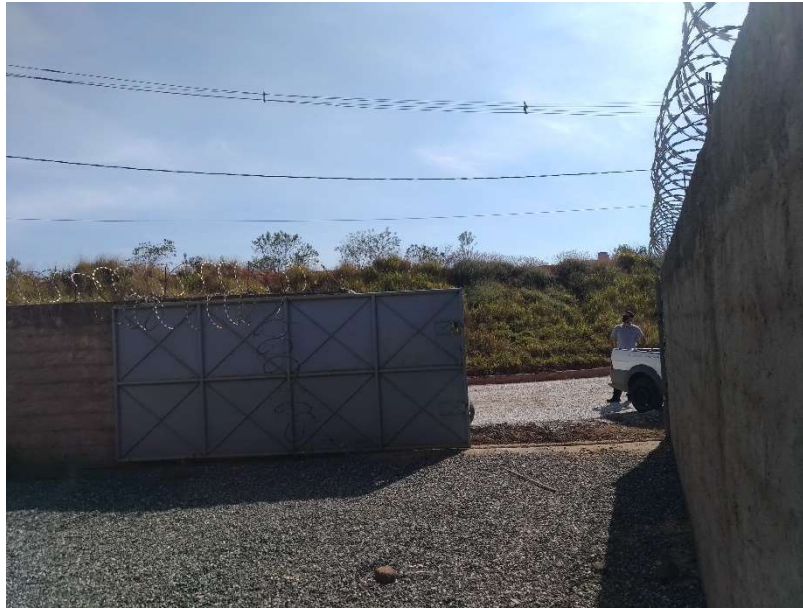
Figura 34 - Portão da entrada - DIQUE 02
