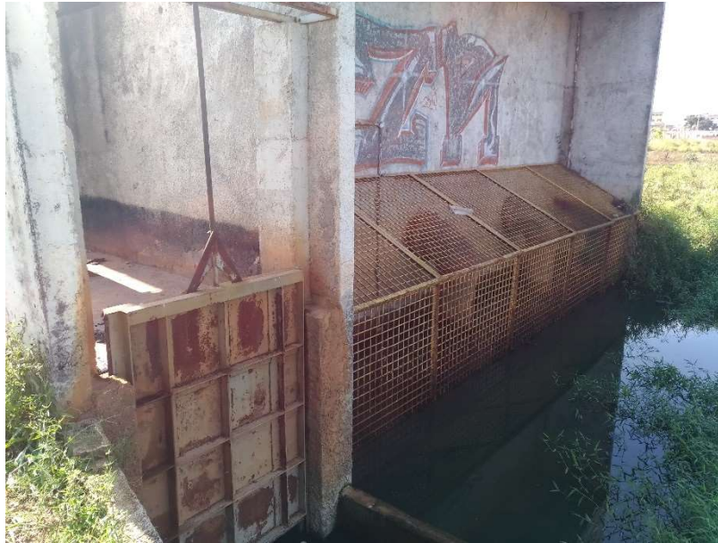
Figura 35 - Telas de Proteção e comporta - DIQUE 02
