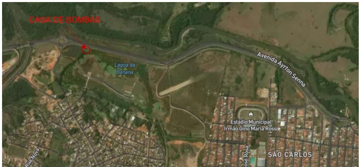
Figura 1 - Localização da casa de bombas da DIQUE 01
