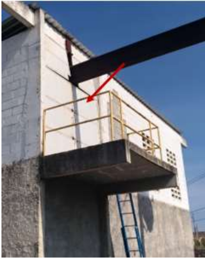
Figura 30 - Porta de acesso - DIQUE 02
