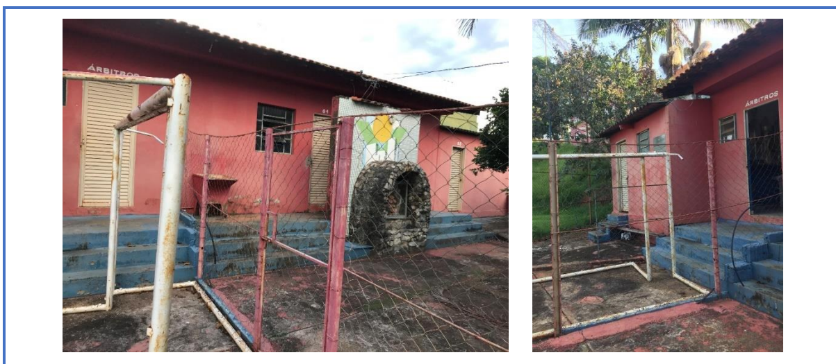
Figura 2 – Área externa dos vestiários
