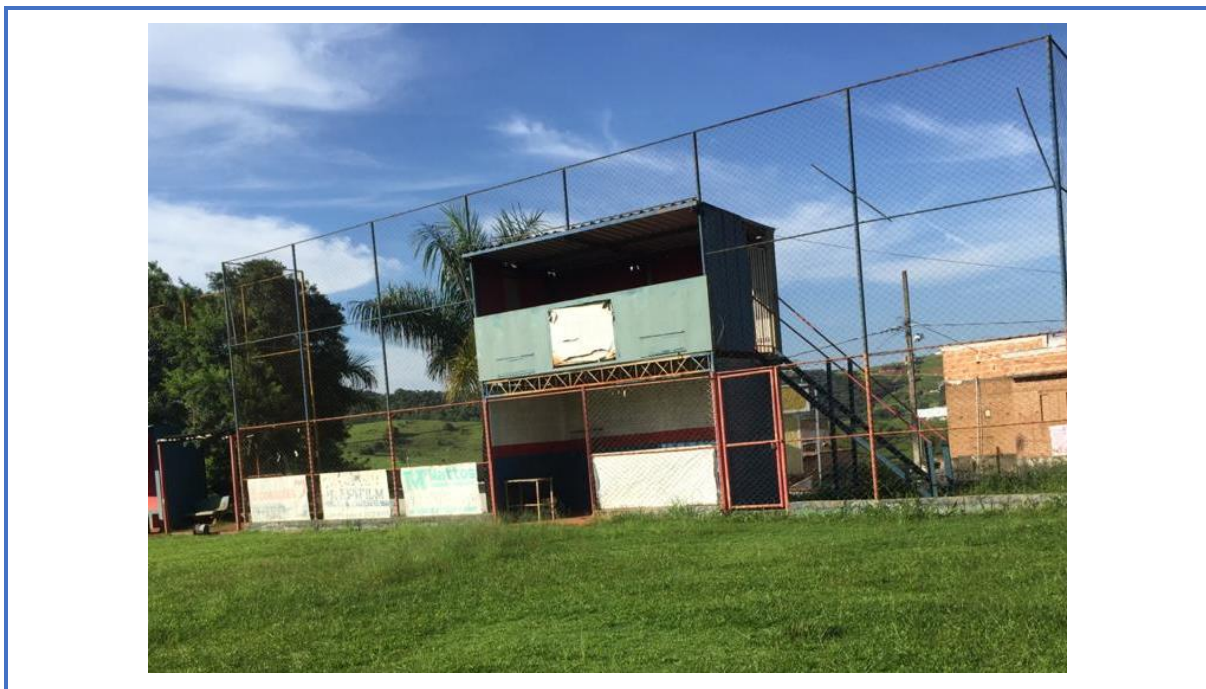
Figura 7 – Cabine de Som
