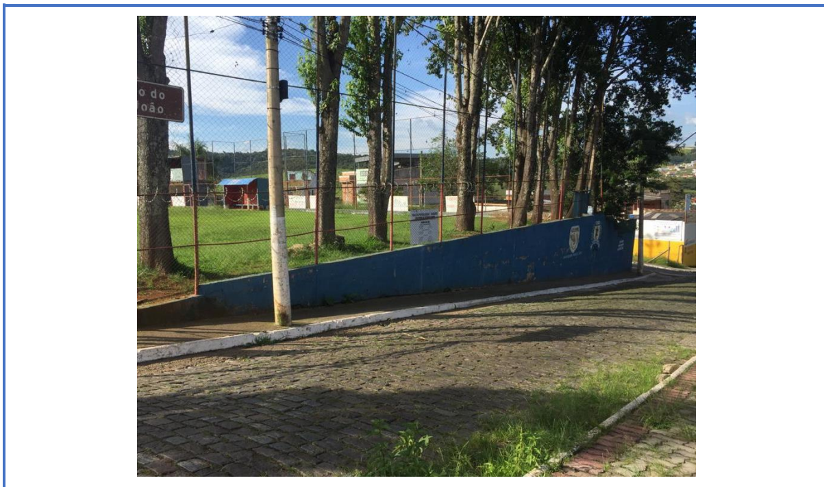
Figura 5 – Muro de divisa
