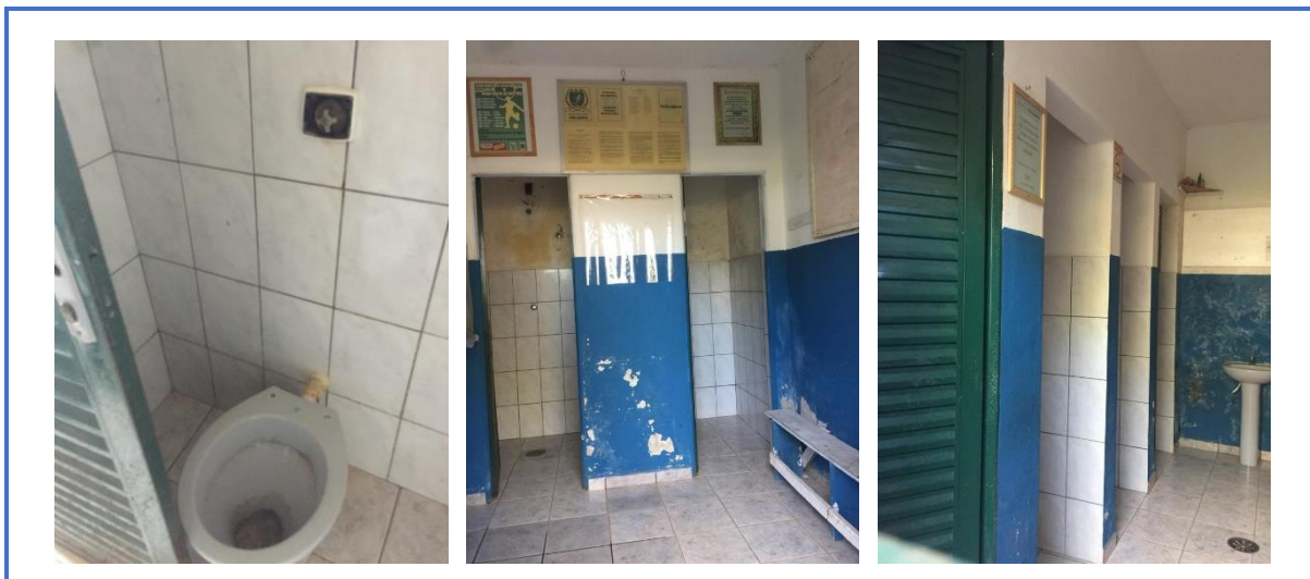
Figura 9 – Revestimento cerâmico e louças vestiários
