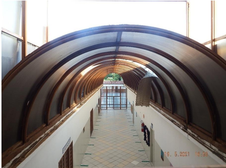
**Figura 3 - Cobertura Policarbonato Danificada**
