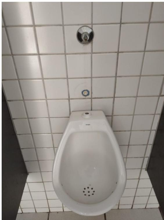
**Figura 30 - Mictório para Instalação de Engate e Acabamento de Registro**
