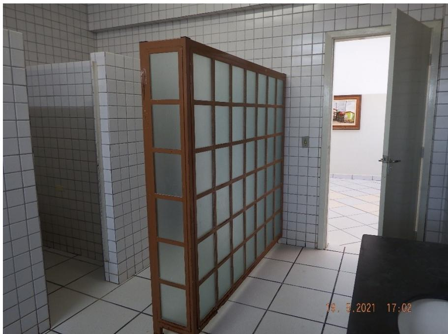
**Figura 13 - Divisória Metálica**
