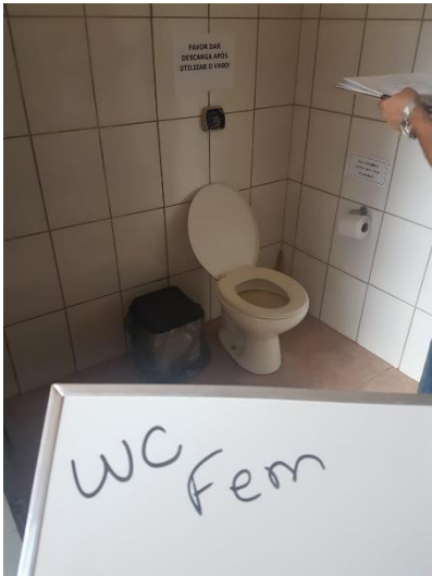
BANHEIRO A SER REFORMADO
