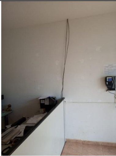
LOCAL PARA FAZER A BANCADA EM ALVENARIA
