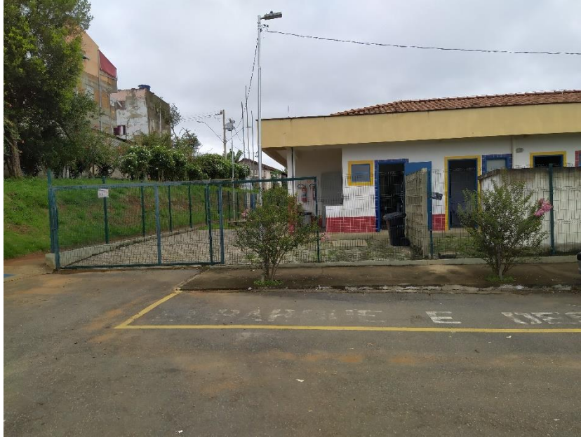
Figura 10 - Gradil a ser removido e reinstalado
