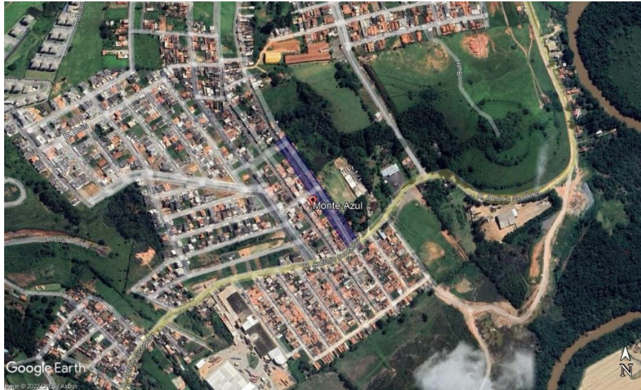
Figura 1-1 – Área de intervenção da obra
