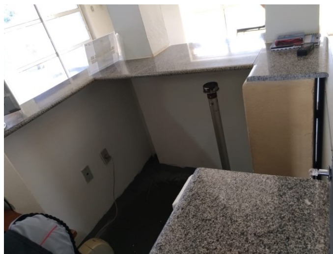
Figura 3 - Bancadas a serem removidas
