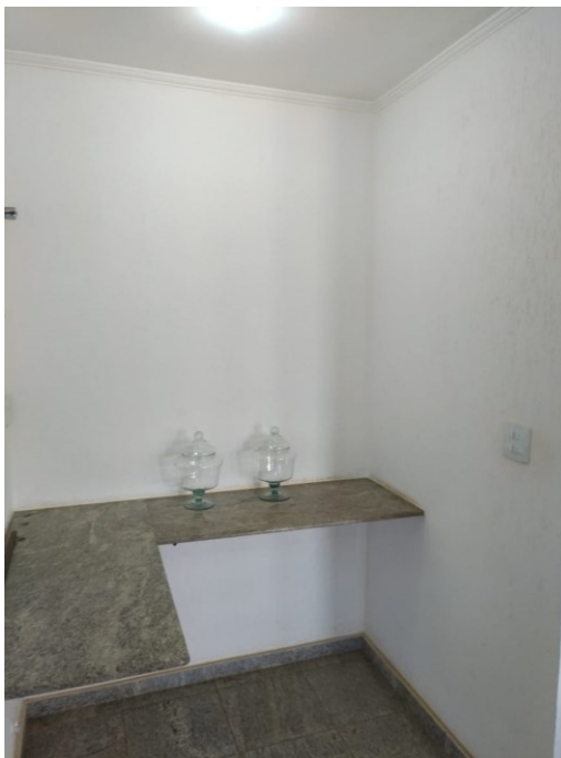
Figura 7 - Bancada da Sala Vip
