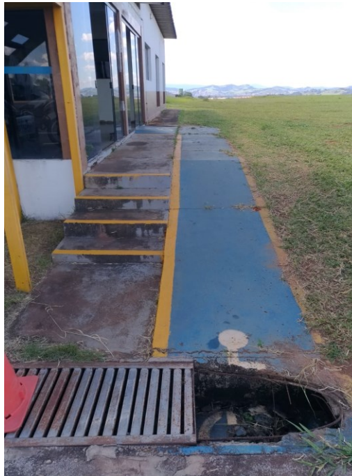
Figura 19 - Rampa e Escada nos Fundos
