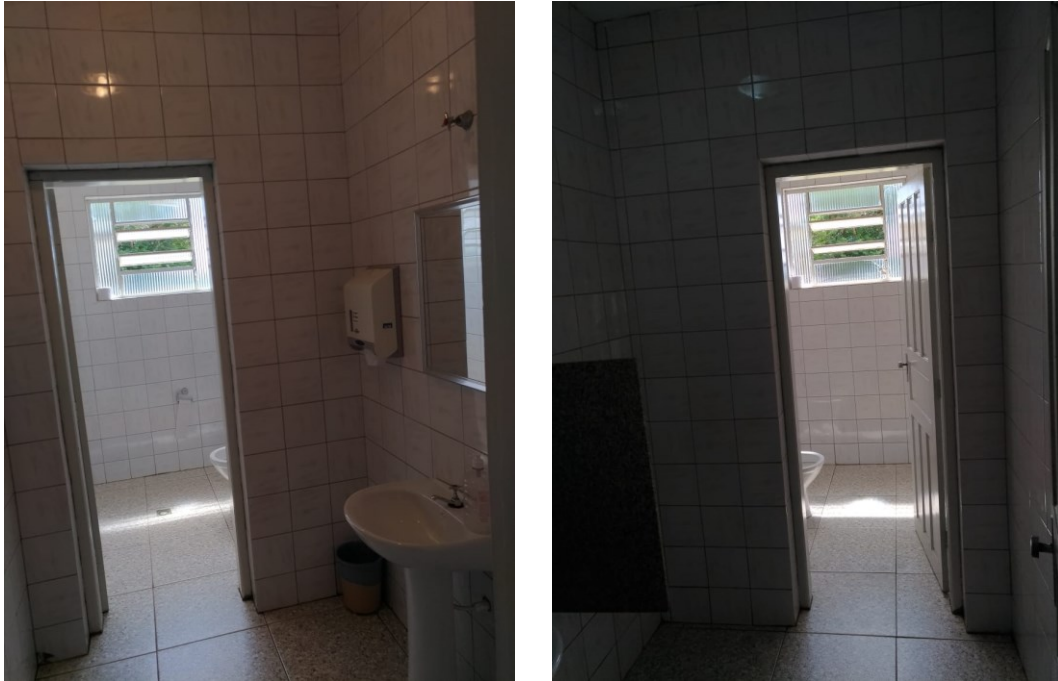
Figura 8 - Sanitários do Lounge
