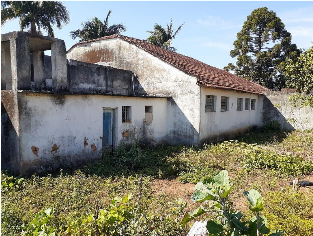
Figura 4-2 – Edificação a ser demolida – Vista dos Fundos
