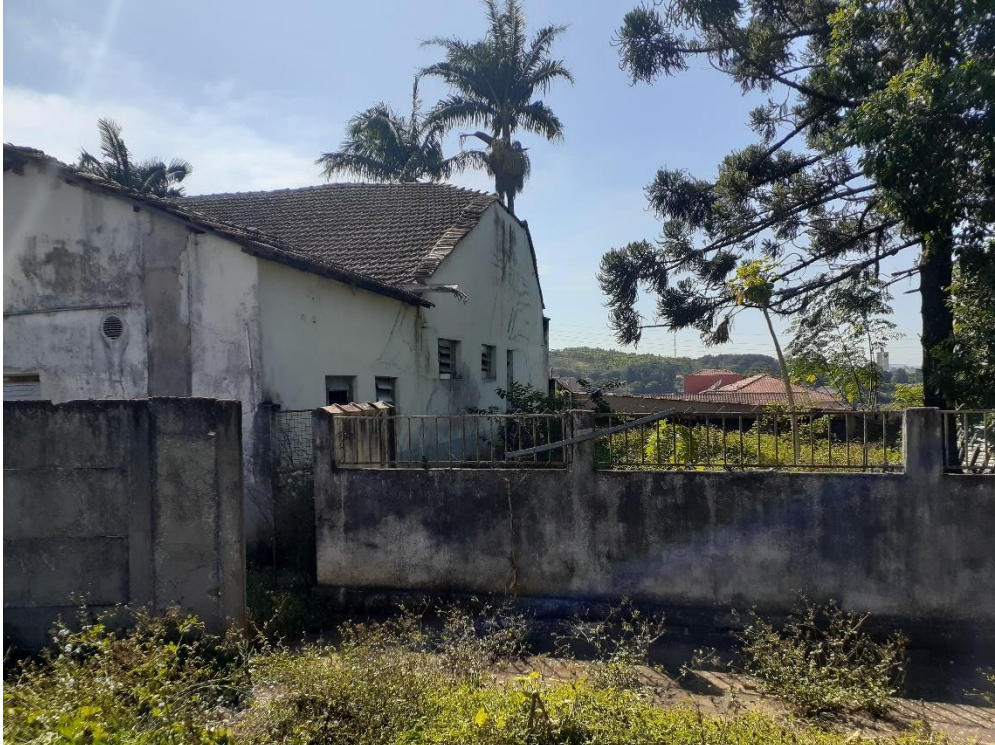
Figura 4-3 – Edificação a ser demolida – Vista Lateral
