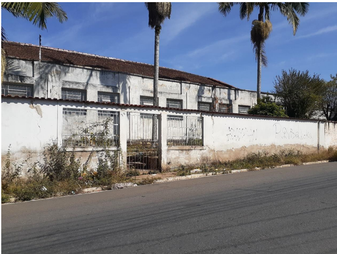
Figura 4-1 – Edificação a ser demolida – Vista Frontal
