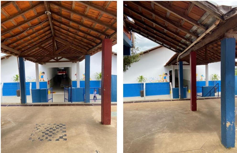
Figura 4-8 – Telhas e trama de madeira a serem removidas
