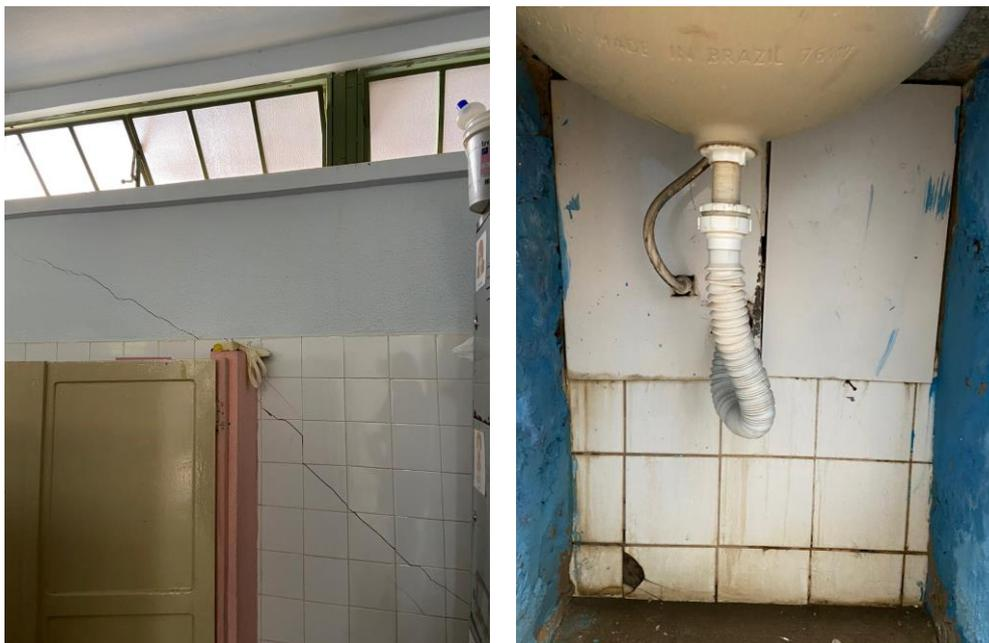
Figura 4-3 – Revestimentos a serem demolidos
