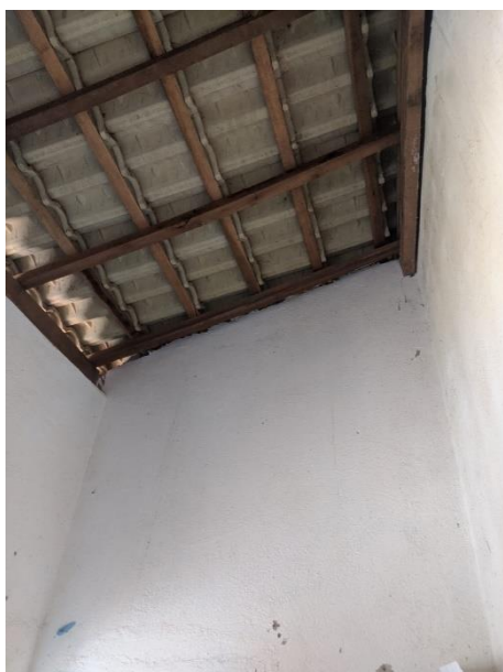
Figura 4-5 – Tesoura e Trama de madeira, Telhas a serem removidas da Guarita e do Setor de Manutenção
