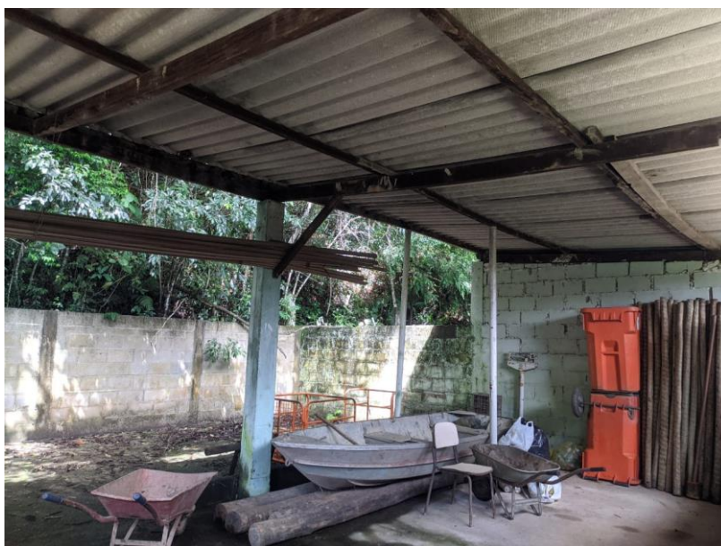
Figura 4-5 – Tesoura e Trama de madeira, Telhas a serem removidas da Guarita e do Setor de Manutenção
