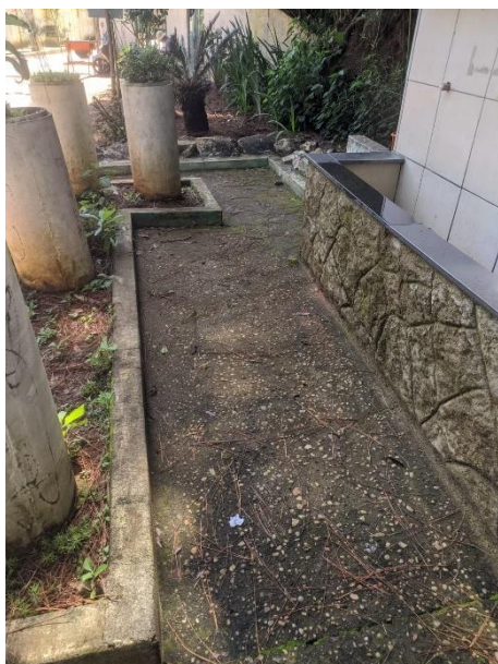
Figura 4-9 – Piso cimentado ou contrapiso a ser demolido da Fonte e do Setor de Manutenção
