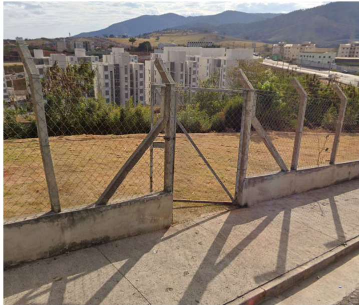
Figura 7-3 – Portão a ser removido
