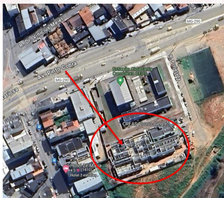
Figura 2 - Local de execução das coberturas do CEMAPA
