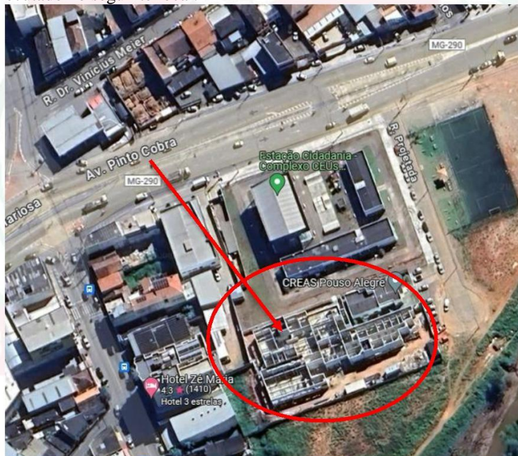
Figura 1 - Local de execução das coberturas do CEMAPA
