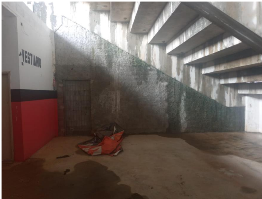
Figura 4-1 – Parede a ser demolida
