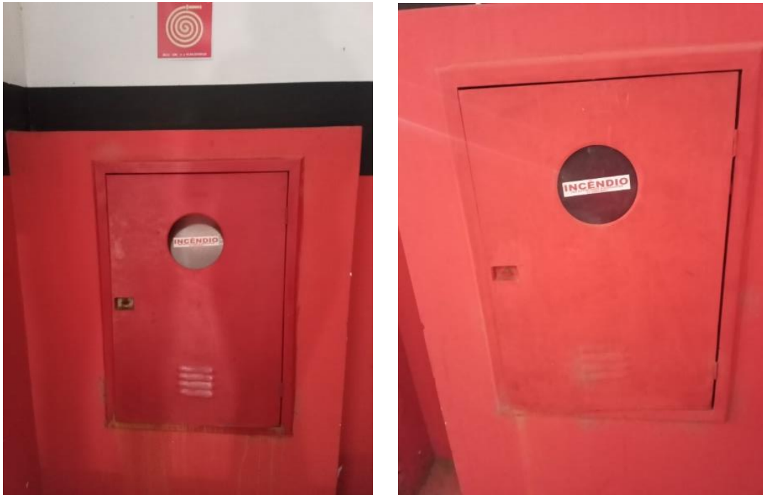
Figura 5-2 – Paredes a serem pintadas
