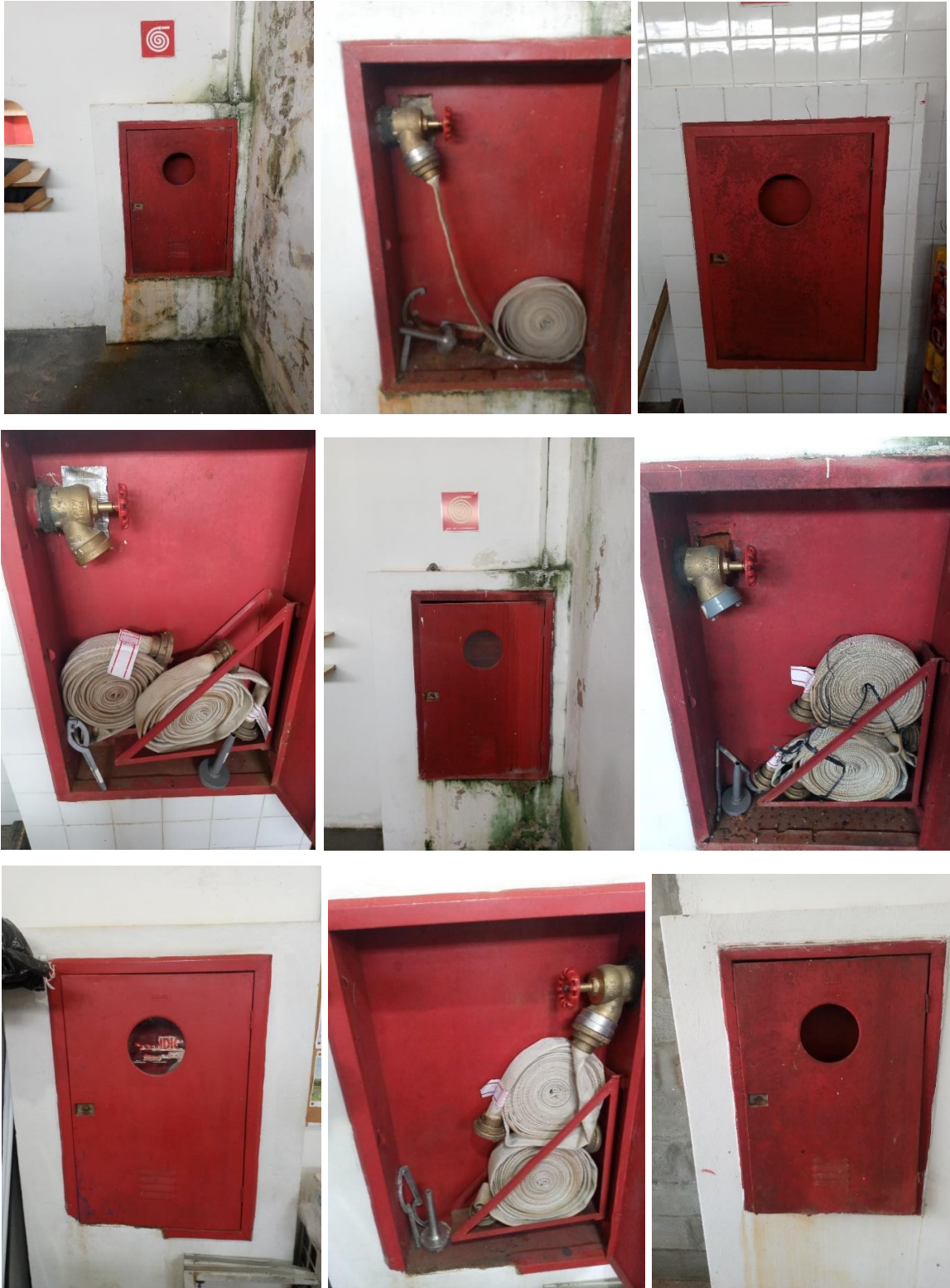
Figura 4-2 – Hidrantes a serem removidos
