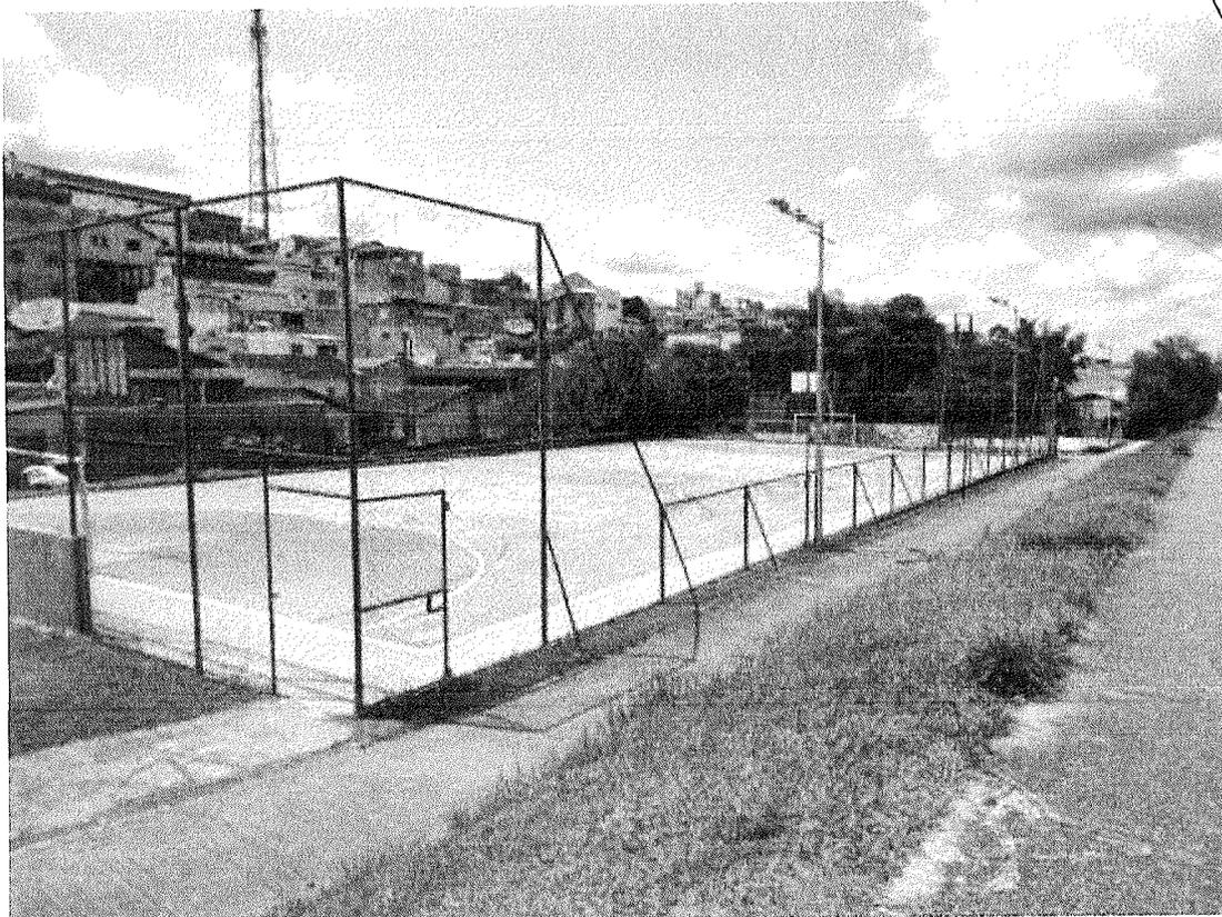
**Figura 4 – Passeio de concreto a ser removido**
