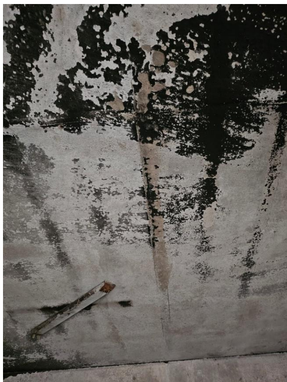
Figura 9-7 – Fissura interna 02 - Teto
