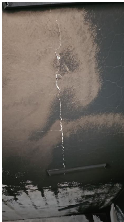
Figura 9-8 – Fissura interna 03 - Teto
