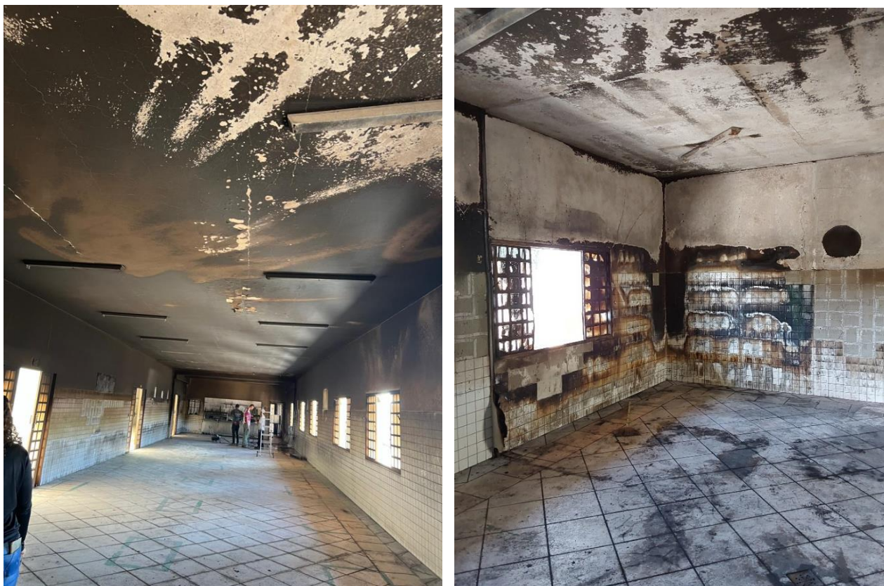
Figura 6-2 – Revestimentos do Refeitório a serem removidos
