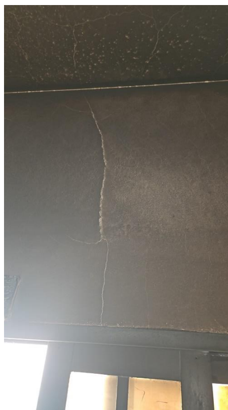
Figura 9-4 – Fissura interna 04 - Parede
