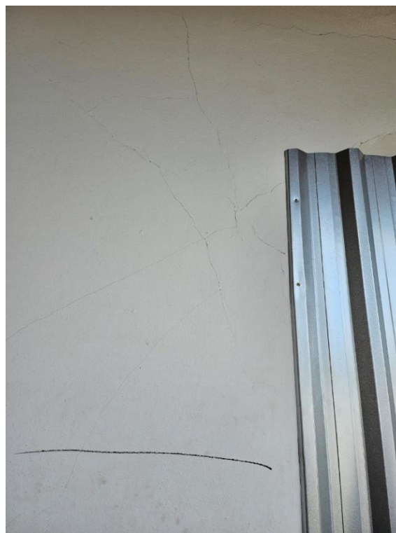
Figura 9-2 – Fissura externa 02 - Parede
