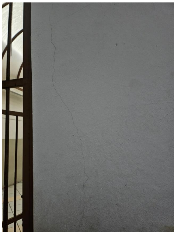
Figura 9-1 – Fissura externa 01 - Parede
