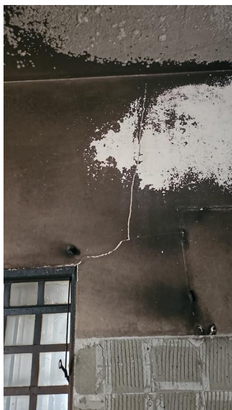
Figura 9-3 – Fissura interna 03 - Parede
