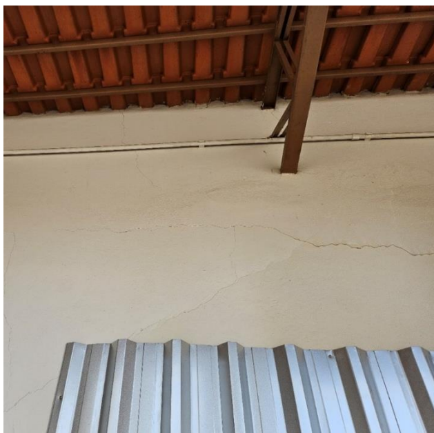
Figura 9-13 – Trinca externa 02 - Parede
