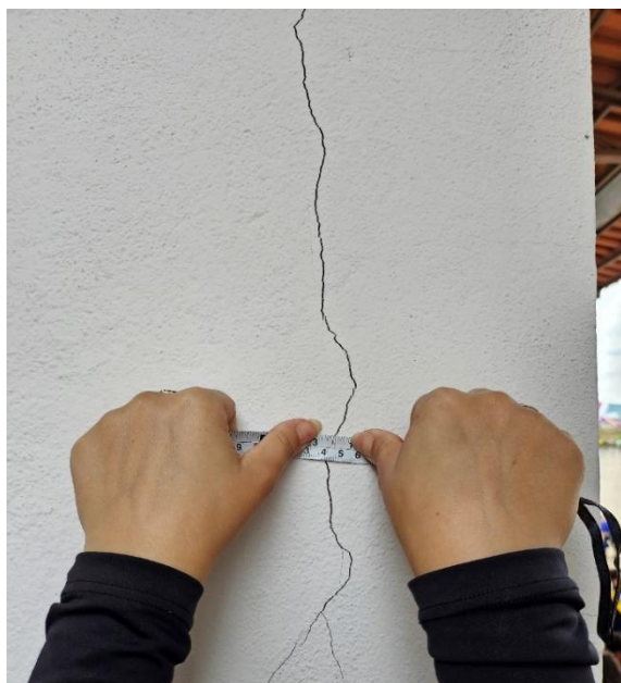
Figura 9-12 – Trinca externa 01 - Parede
