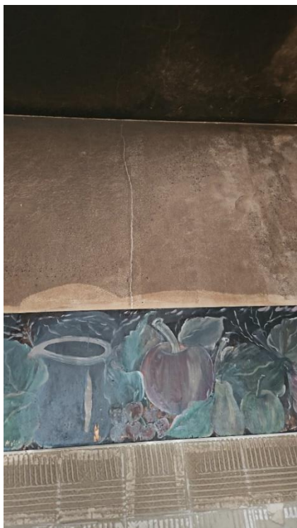
Figura 9-5 – Fissura interna 05 - Parede
