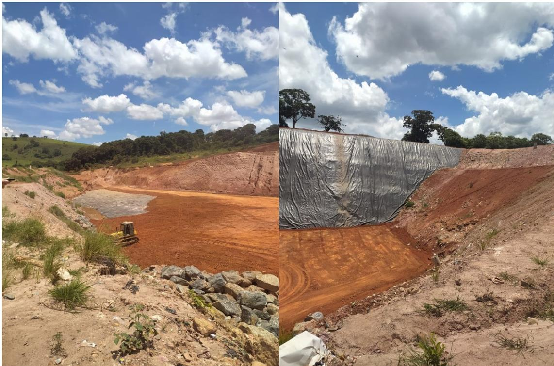
**Figura 32 - Áreas do aterro impermeabilizadas para o recebimento de resíduos**
